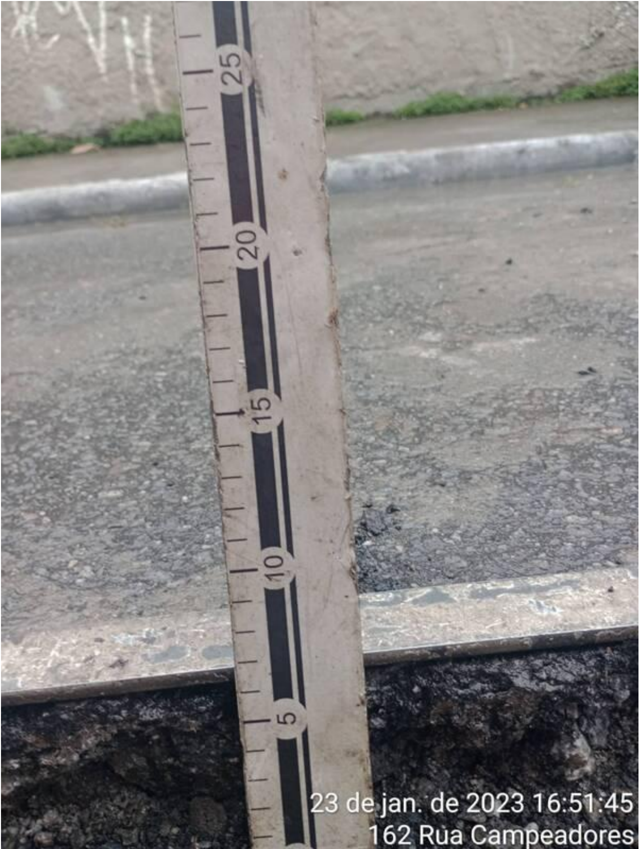
24 | ACABAMENTO → Nível com régua após caixa pronta: Item de OS APLICAÇÃO DE MASSA Origem: 6608901 - (Foto Capturada Em: 08/03/23 12:59, Por: mxintadm)
