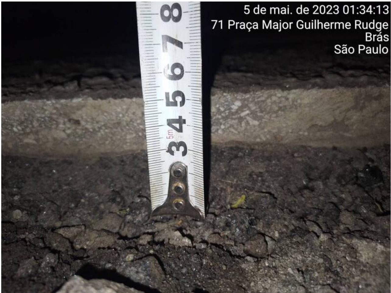
10 | APLICAÇÃO → Aplicação da Emulsão: Item de OS APLICAÇÃO DE MASSA Origem: 6902534 - (Foto Capturada Em: 08/05/23 14:52, Por: mxintadm)
