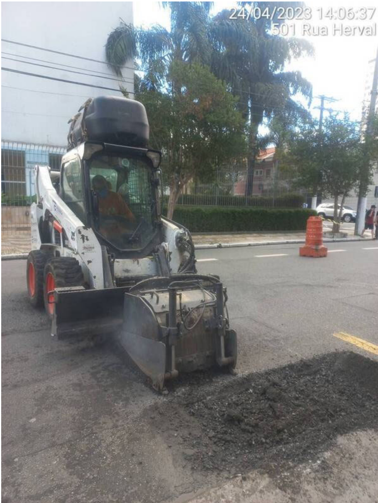
5 | RECORTE → Limpeza da caixa com a trena de 1m, após a serra clipper: Item de OS RECORTE Origem: 6924446 - (Foto Capturada Em: 25/04/23 17:33, Por: mxintadm)
