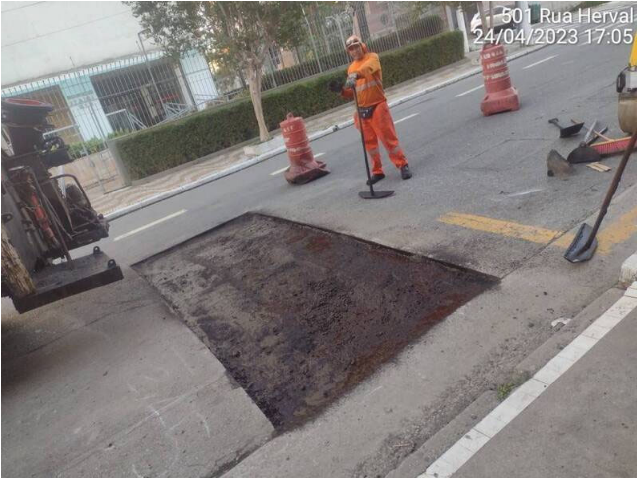
5 | COMPACTAÇÃO → Base: Item de OS APLICAÇÃO DE MASSA Origem: 6924447 - (Foto Capturada Em: 25/04/23 17:33, Por: mxintadm)
