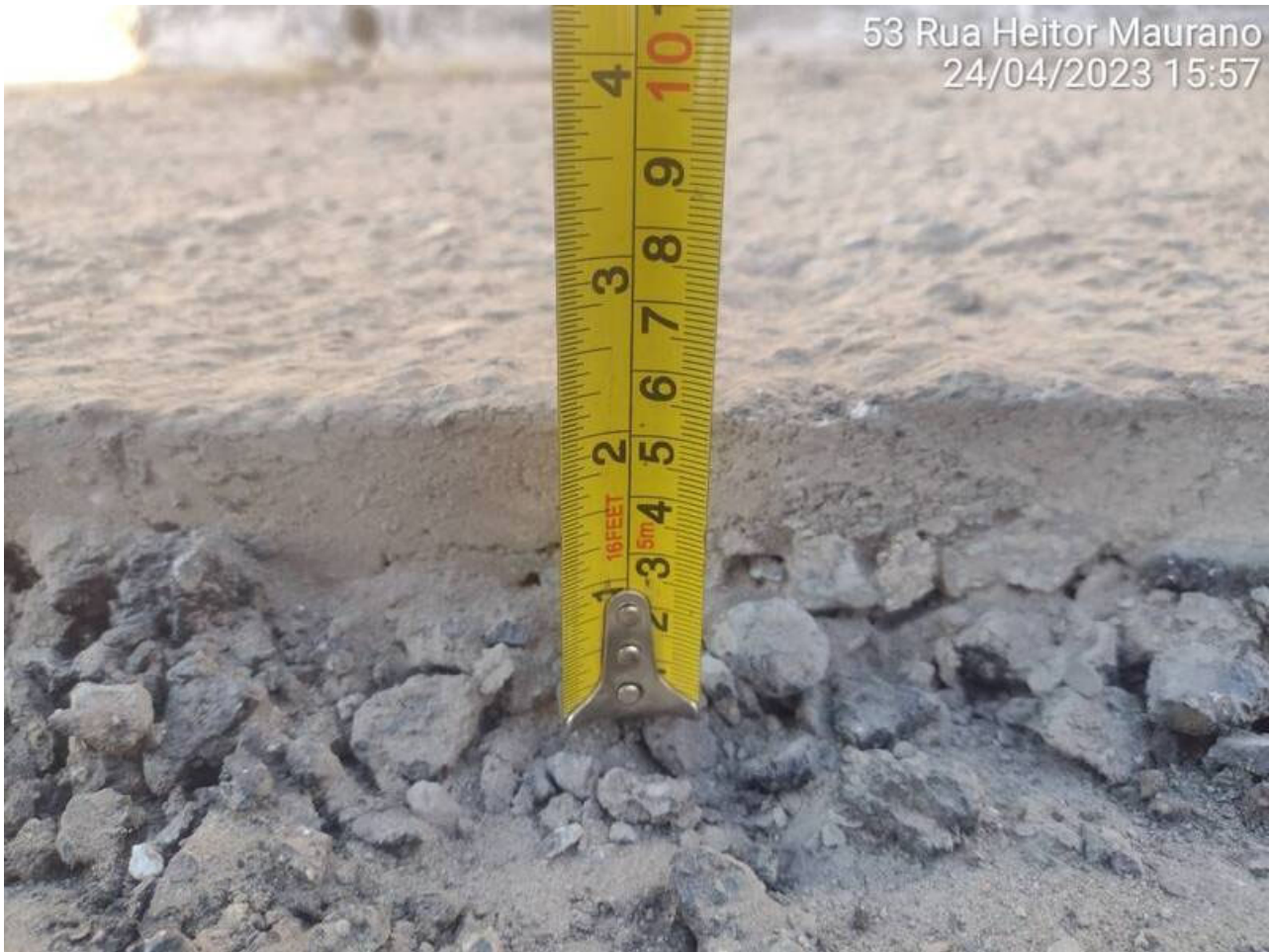
6 | APLICAÇÃO → Aplicação Massa Asfáltica (haste): Item de OS APLICAÇÃO DE MASSA Origem: 6906127 - (Foto Capturada Em: 25/04/23 17:33, Por: mxintadm)
