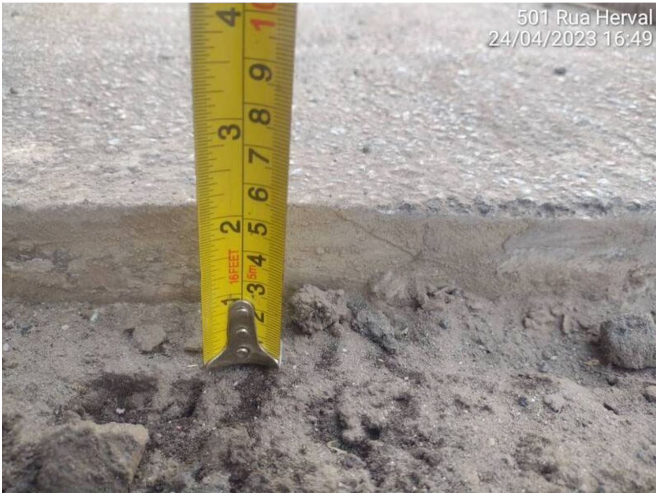
4 | APLICAÇÃO → Aplicação da Emulsão: Item de OS APLICAÇÃO DE MASSA Origem: 6924447 - (Foto Capturada Em: 25/04/23 17:33, Por: mxintadm)
