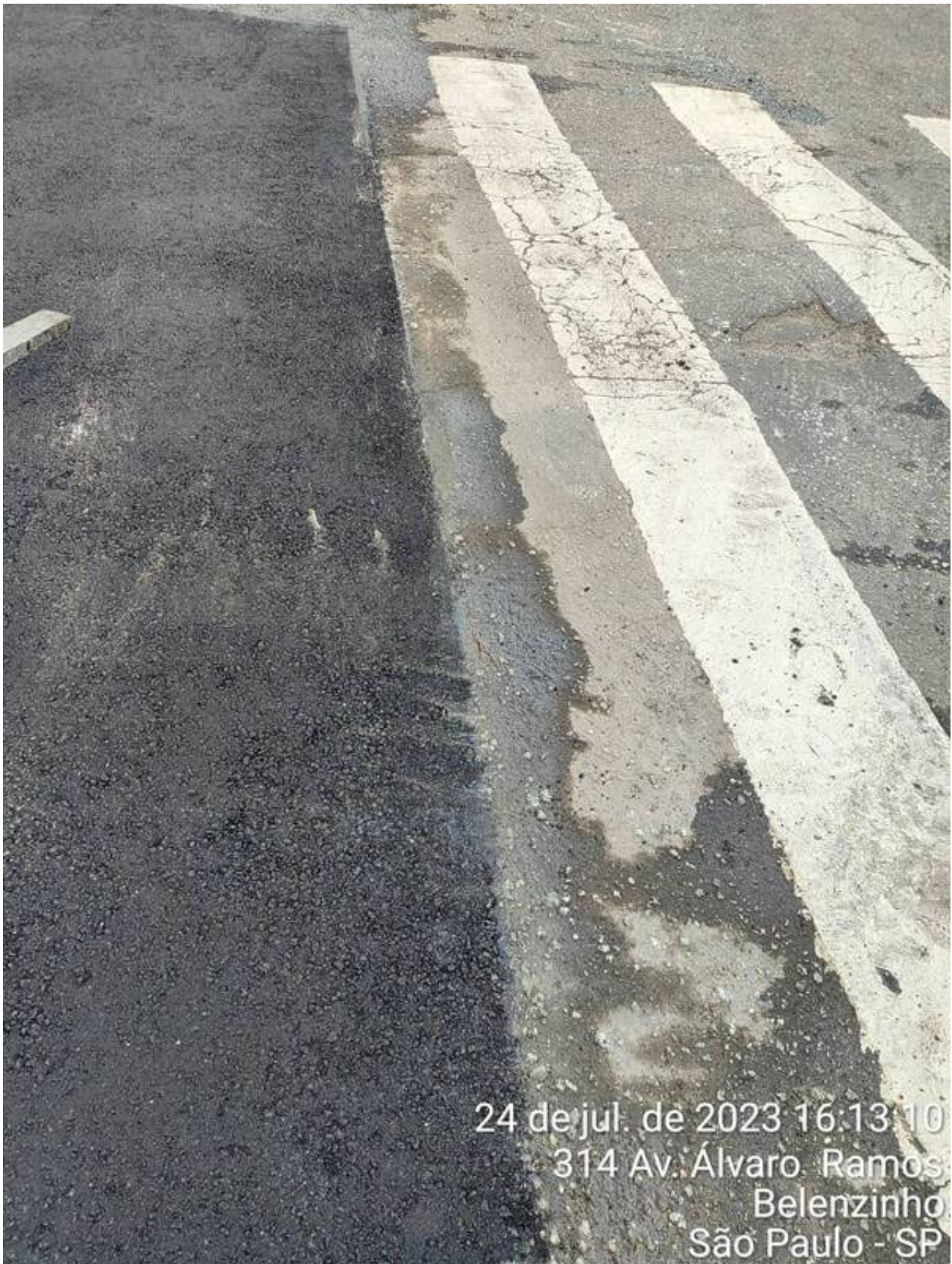
12 | ACABAMENTO → Nível com régua após caixa pronta: Item de OS APLICAÇÃO DE MASSA Origem: 7527159 - (Foto Capturada Em: 25/07/23 06:28, Por: mxintadm)
