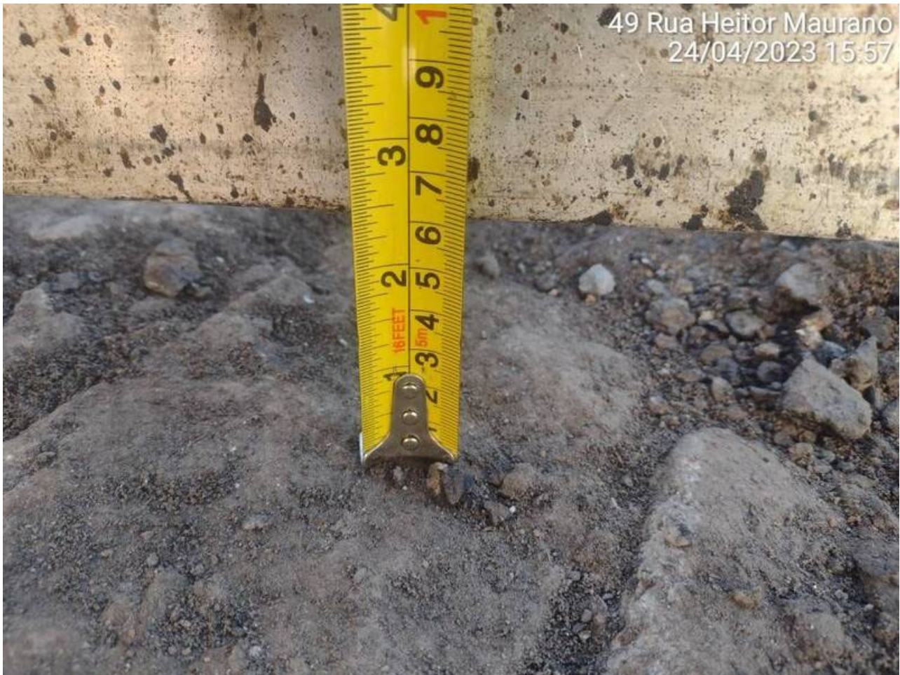
11 | ACABAMENTO → Nível com régua após caixa pronta: Item de OS APLICAÇÃO DE MASSA Origem: 6906127 - (Foto Capturada Em: 25/04/23 17:33, Por: mxintadm)
