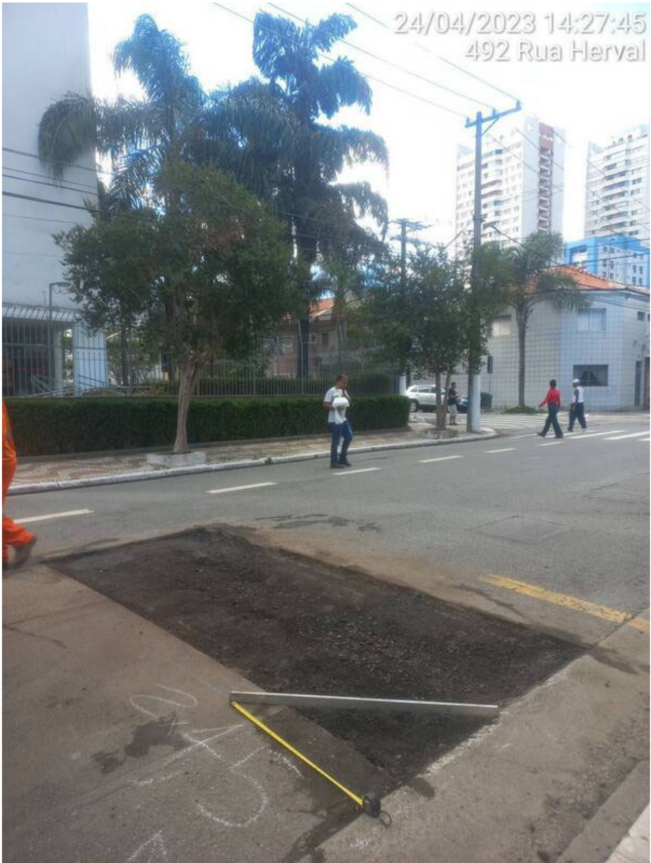
6 | RECORTE → Limpeza da caixa com a trena de 1m, após a serra clipper: Item de OS RECORTE Origem: 6924446 - (Foto Capturada Em: 25/04/23 17:33, Por: mxintadm)
