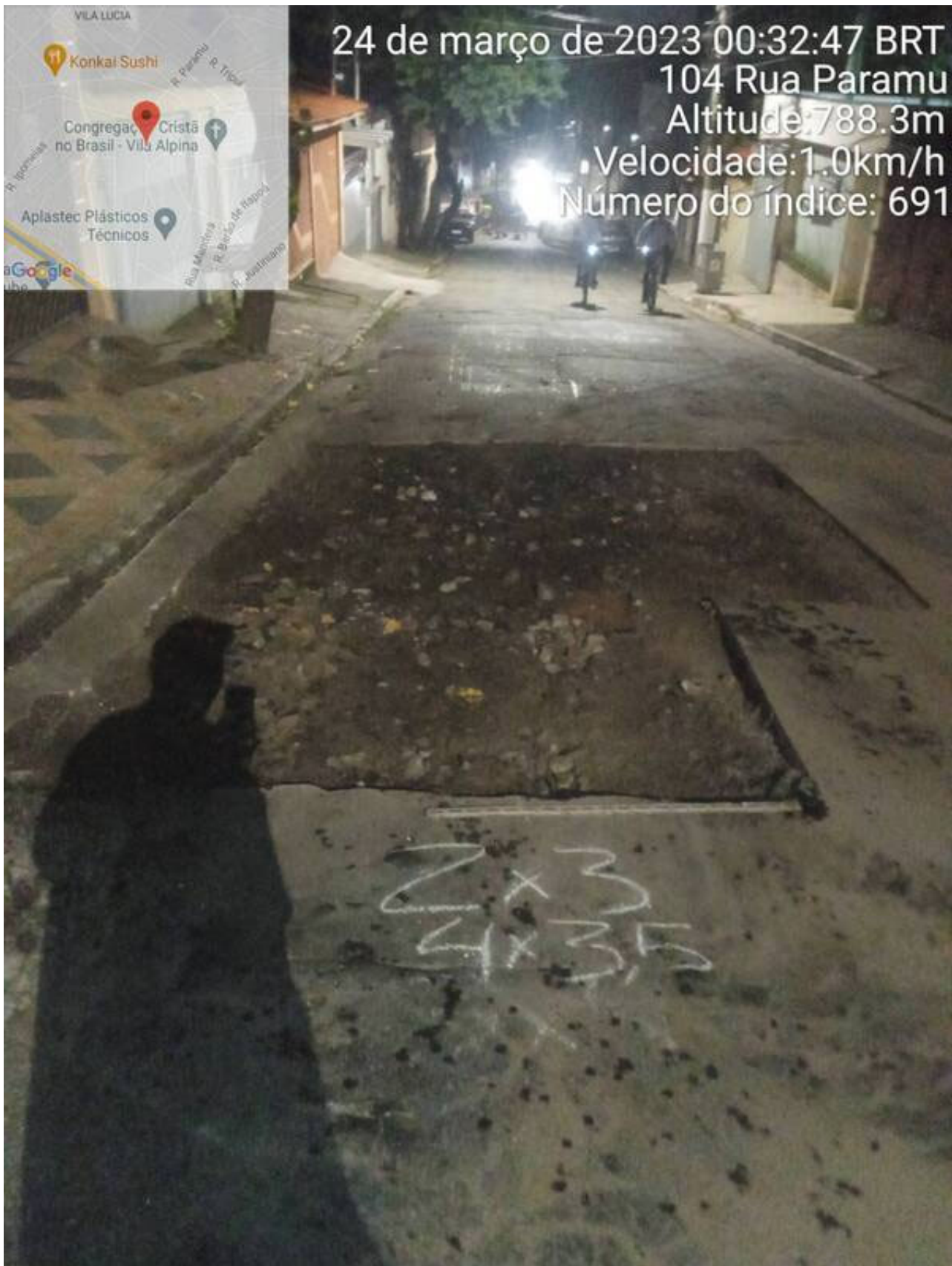
3 | RECORTE → Fresadora e serra clipper: Item de OS RECORTE Origem: 6877493 - (Foto Capturada Em: 24/03/23 02:26, Por: mxintadm)
