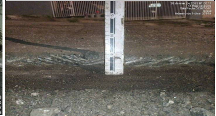
6 | ACABAMENTO → Nivel com régua após caixa pronta: Item de OS APLICAÇÃO DE MASSA Origem: 6896001 (30/03/23 14:37 MXINTADM)
