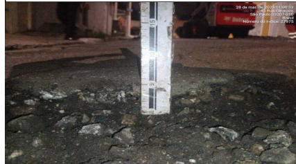
7 | ACABAMENTO → Irregularidade da via após caixa pronta: Item de OS APLICAÇÃO DE MASSA Origem: 6896001 (30/03/23 14:37 MXINTADM)
