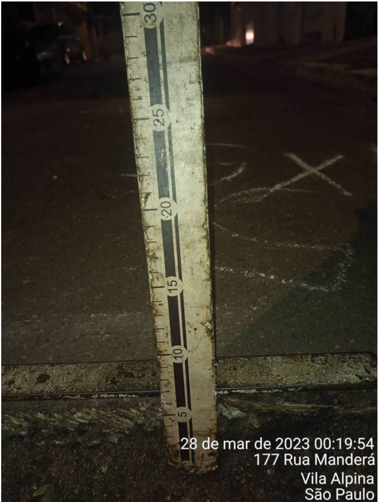
4 | PROFUNDIDADE → Registro da profundidade mais rasa da caixa com uso da trena: Item de OS APLICAÇÃO DE MASSA Origem: 6894429 - (Foto Capturada Em: 28/03/23 14:27, Por: mxintadm)
