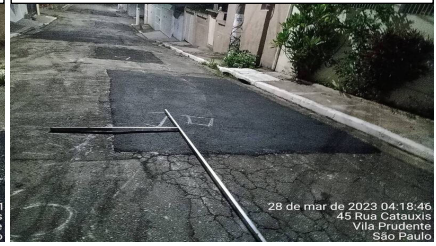
9 | COMPACTAÇÃO → Base: Item de OS APLICAÇÃO DE MASSA Origem: 6896001 (30/03/23 14:37 MXINTADM)
