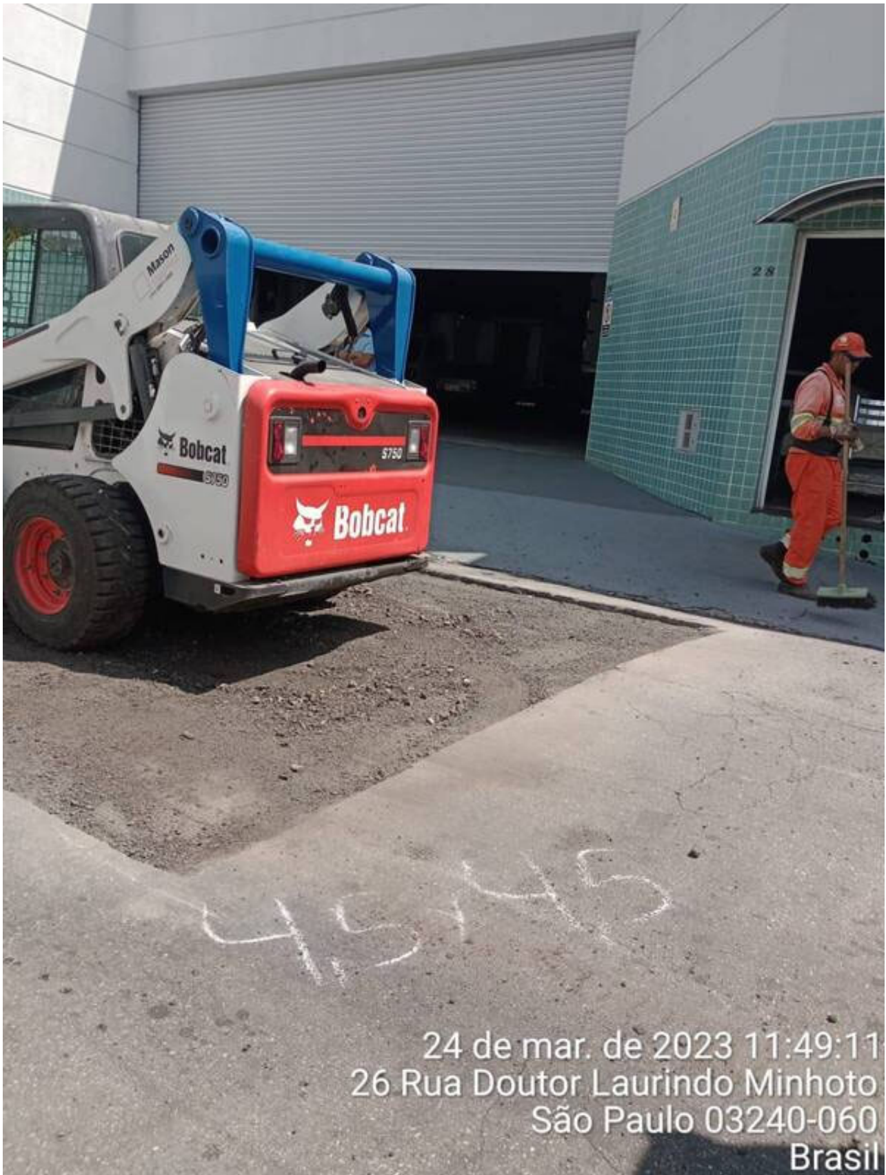
4 | RECORTE → Limpeza da caixa com a trena de 1m, após a serra clipper: Item de OS RECORTE Origem: 6889899 - (Foto Capturada Em: 27/03/23 14:34, Por: mxintadm)
