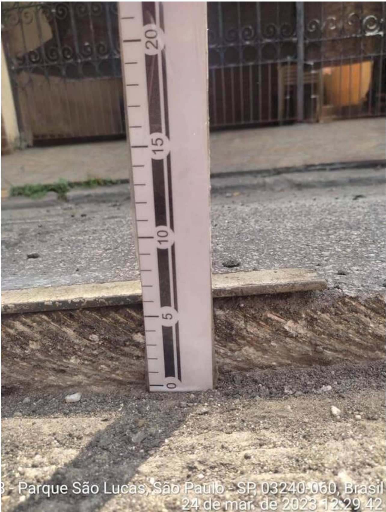
21 | ACABAMENTO → Nível com régua após caixa pronta: Item de OS APLICAÇÃO DE MASSA Origem: 6877460 - (Foto Capturada Em: 29/03/23 15:06, Por: mxintadm)
