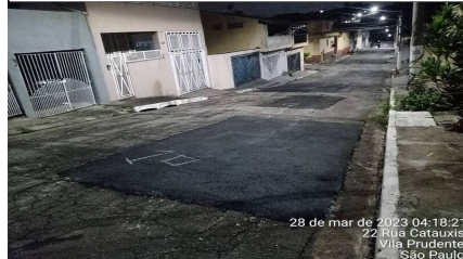
10 | ACABAMENTO → Irregularidade da via após caixa pronta: Item de OS APLICAÇÃO DE MASSA Origem: 6896001 (30/03/23 14:37 MXINTADM)
