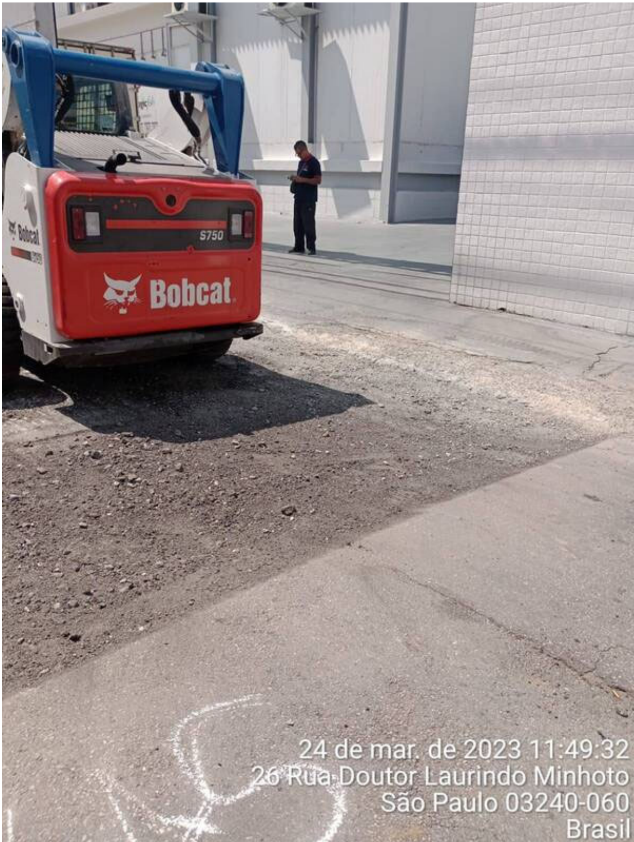
5 | RECORTE → Limpeza da caixa com a trena de 1m, após a serra clipper: Item de OS RECORTE Origem: 6889902 - (Foto Capturada Em: 27/03/23 14:34, Por: mxintadm)
