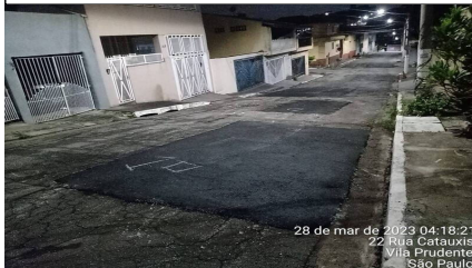
10 | ACABAMENTO → Irregularidade da via após caixa pronta: Item de OS APLICAÇÃO DE MASSA Origem: 6896001 (30/03/23 14:37 MXINTADM)
