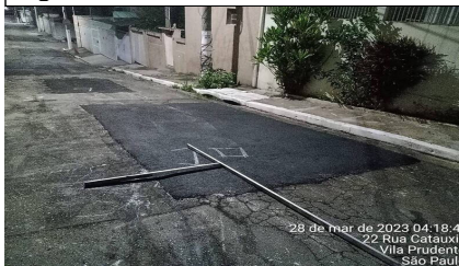
5 | APLICAÇÃO → Aplicação Massa Asfáltica (haste): Item de OS APLICAÇÃO DE MASSA Origem: 6896001 (30/03/23 14:37 MXINTADM)
