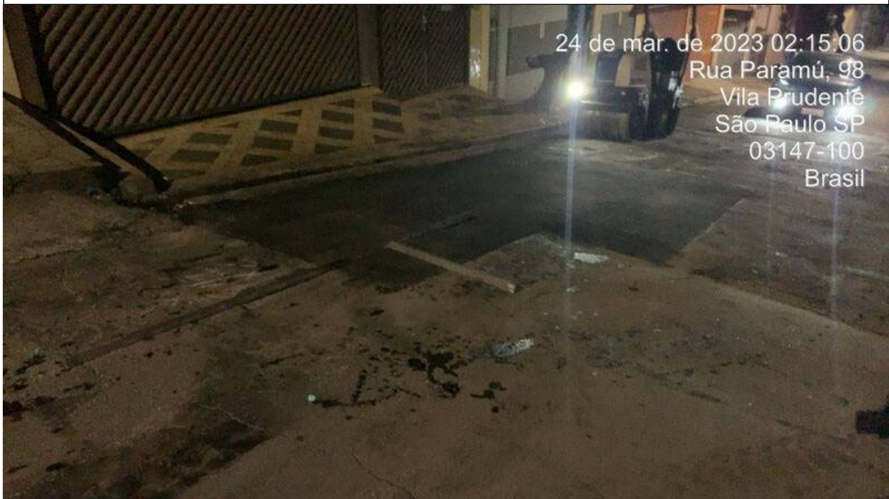
13 | APLICAÇÃO → Aplicação da Emulsão: Item de OS APLICAÇÃO DE MASSA Origem: 6877494 - (Foto Capturada Em: 27/03/23 10:49, Por: mxintadm)
