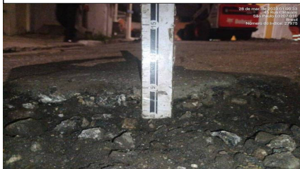
7 | ACABAMENTO → Irregularidade da via após caixa pronta: Item de OS APLICAÇÃO DE MASSA Origem: 6896001 (30/03/23 14:37 MXINTADM)
