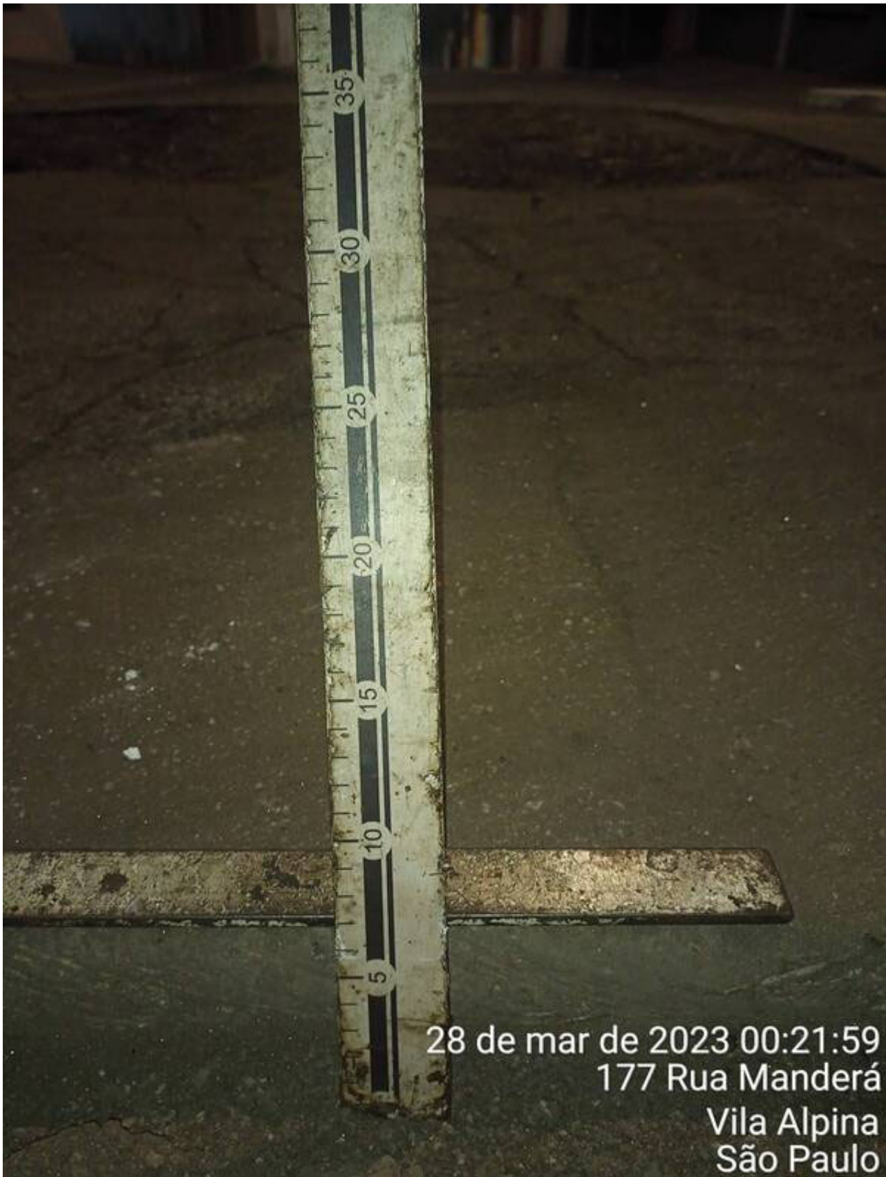
11 | ACABAMENTO → Nível com régua após caixa pronta: Item de OS APLICAÇÃO DE MASSA Origem: 6877479 - (Foto Capturada Em: 28/03/23 14:27, Por: mxintadm)
