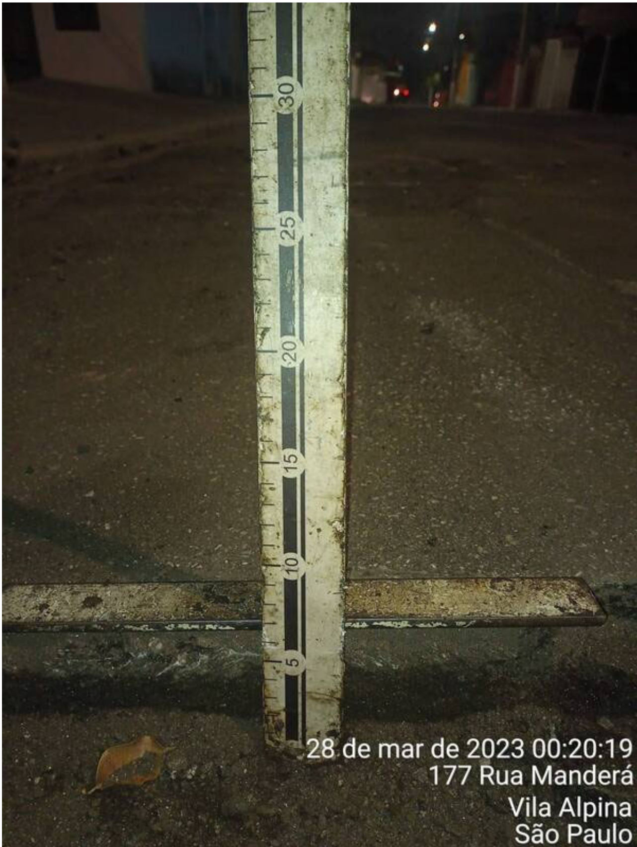
5 | ACABAMENTO → Nível com régua após caixa pronta: Item de OS APLICAÇÃO DE MASSA Origem: 6894429 - (Foto Capturada Em: 28/03/23 14:27, Por: mxintadm)
