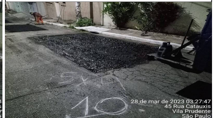
12 | ACABAMENTO → Irregularidade da via após caixa pronta: Item de OS APLICAÇÃO DE MASSA Origem: 6896001 (30/03/23 14:37 MXINTADM)
