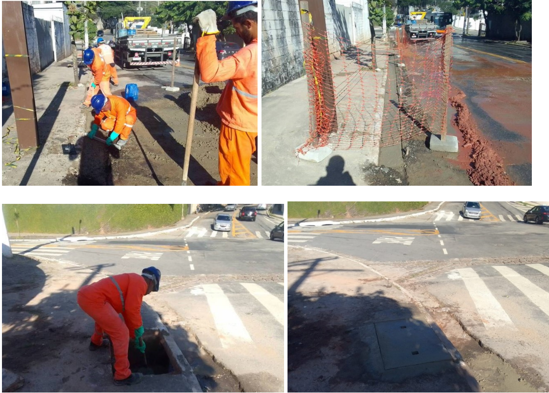
OS 6527760 – MANUTENÇÃO E CONSERVAÇÃO DE GALERIAS
