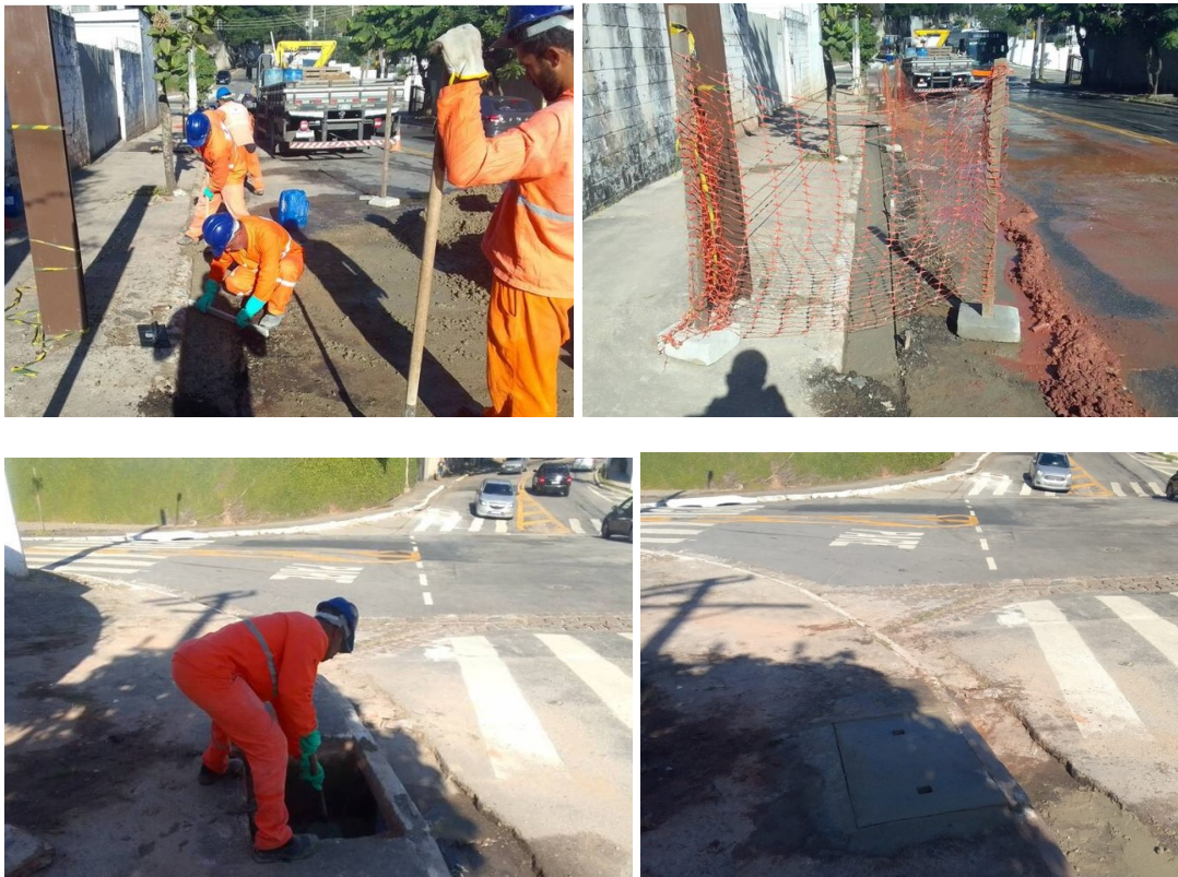
OS 6527760 – MANUTENÇÃO E CONSERVAÇÃO DE GALERIAS
