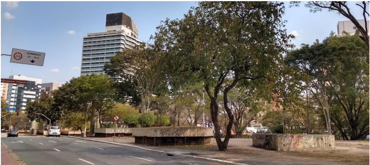
Vista da Rua Vergueiro (direção Norte) com as estruturas do Sistema Metroviário. (Vistoria 23ago23)
