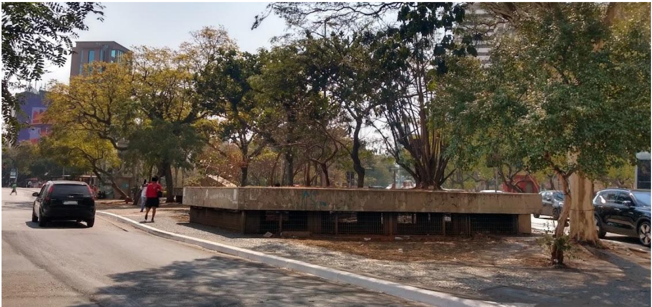
Vista da Rua Vergueiro (direção Centro) com as estruturas do Sistema Metroviário. (Vistoria 23ago23)
