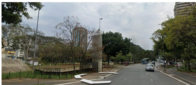
Vista da Rua Vergueiro (direção Norte) que recorta a Praça Rodrigo de Abreu e as estruturas do Sistema Metroviário. GOOGLE EARTH Acesso em 23ago23
