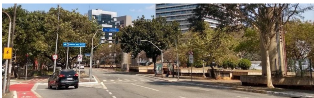
Vista da Rua Vergueiro (direção Sul) que recorta a Praça Rodrigues de Abreu e as estruturas do Sistema Metroviário. (Vistoria 23ago23)
