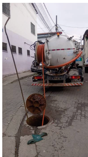
Imagem 1,2 e 3 – Obstrução identificada e desobstruída
