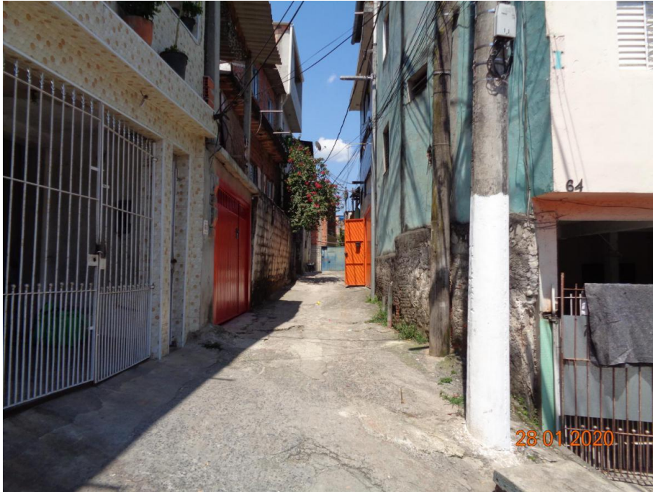
FC.MB-56-03.2: Vista geral do setor MB-56-03 - Risco Médio (R2): observar acesso pavimentado as moradias presentes na viela, próximo a Rua George Saulo.
