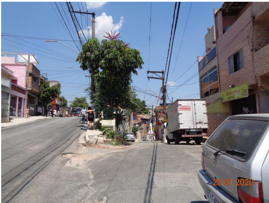
FC.MB-56-03.1: Vista geral do setor MB-56-03 - Risco Médio (R2): observar padrão das moradias construídas em alvenaria, e acesso pavimentado próximo a esquina entre a Rua George Saulo e Estrada do Guavirutuba.
