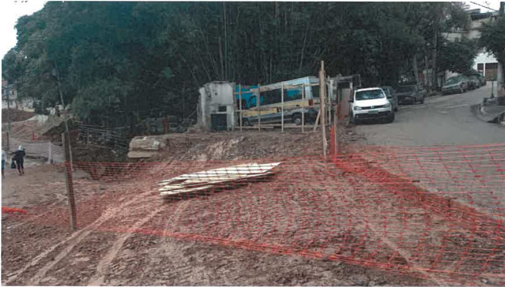
Figura 3: Local após a limpeza e remoção de entulho
