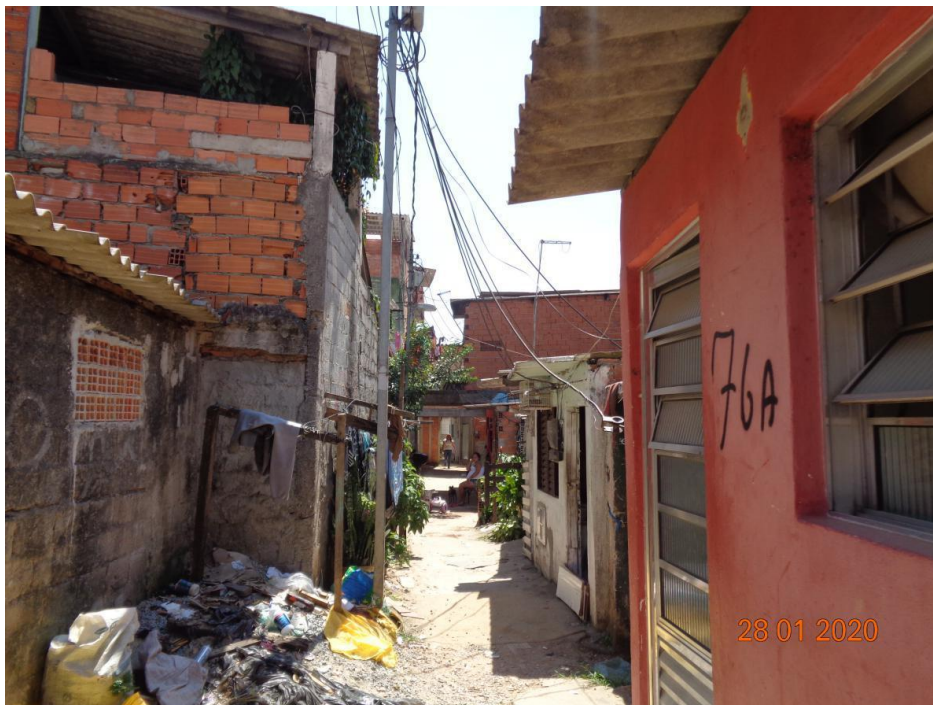
FC.MB-56-01.2: Detalhe do setor MB-56-01 - Risco Médio (R2): observar acesso pavimentado e moradias edificadas sob córrego “canalizado” em viela próximo a Rua Santa Zélia.
