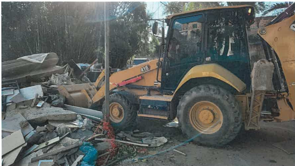
Figura 2: Execução dos serviços de limpeza
