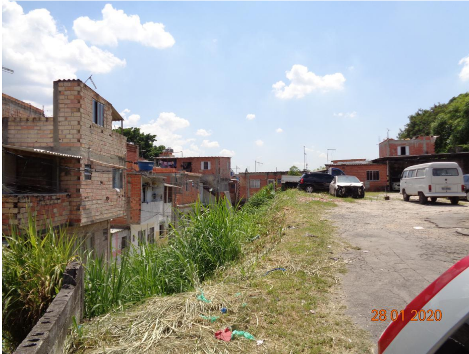
FC.MB-56-02.3: Vista geral do setor MB-56-02 - Risco Alto (R3): observar habitações construídas próximo ao talude marginal do córrego.
