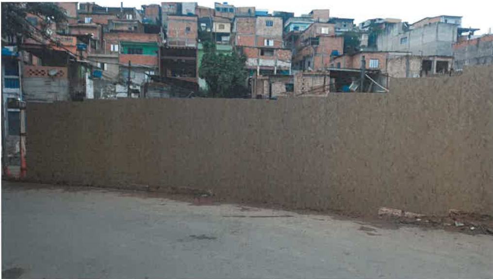
Figura 4: Área isolada com tapumes
