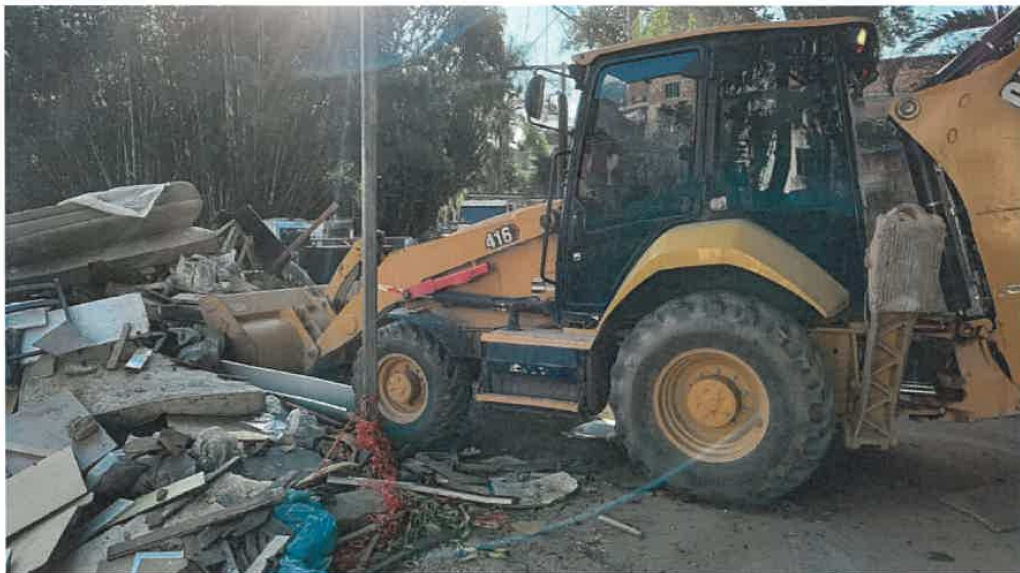
Figura 2: Execução dos serviços de limpeza
