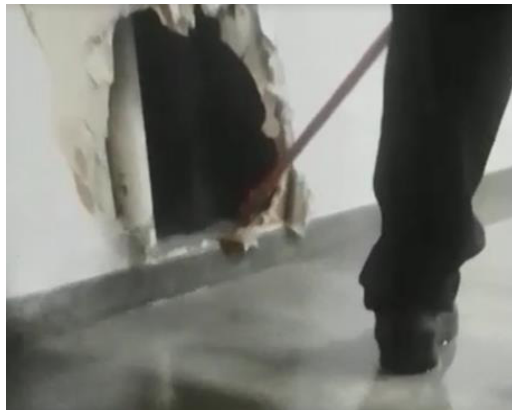
Figura 3: Quebra de parede para localização da tubulação danificada
