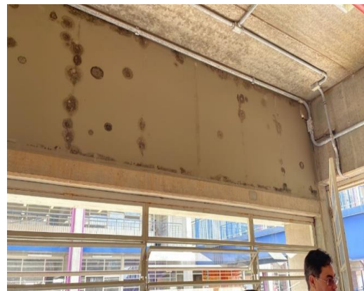
Manutenção de pintura na área da piscina interna.
