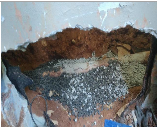
Reposição de apoio da tubulação reparada de forma a aliviar as tensões sobre as conexões e tubulações
