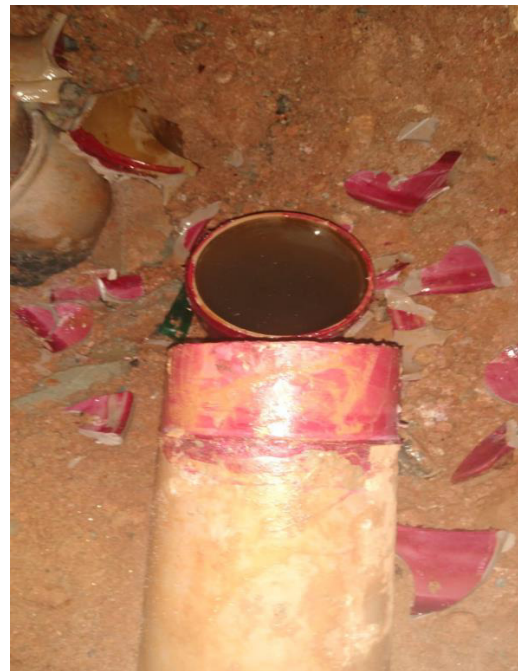
Foto 24: Retirada da tubulação danificada e preparo para realização do reparo
