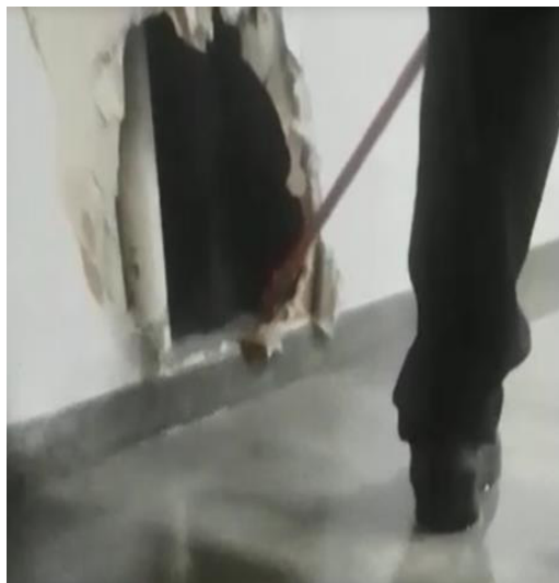
Foto 3: Quebra de parede para localização da tubulação com vazamento
