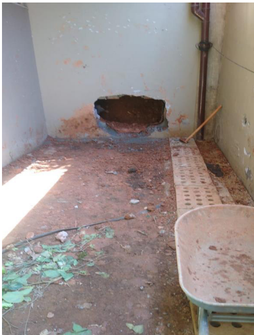
Foto 23: Acesso para retirada de entulho
