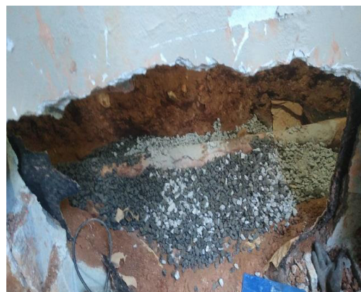
Foto 26: Reposição de apoio da tubulação reparada de forma a aliviar as tensões sobre as conexões e tubulações
