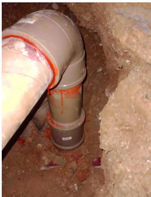
Foto 25: Tubulação reparada com conexões novas e ramal novo
