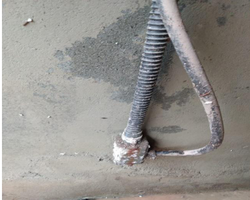
PI 1297 E T Pisc Elétr - Quadro de Comando da Piscina Semi-Olímpica - Foto A1
