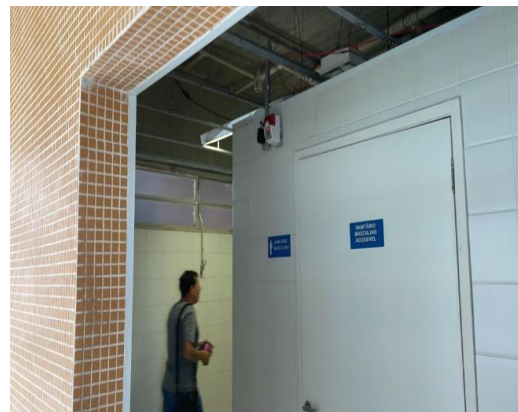
Será feita a vedação na entrada dos vestiários para evitar a umidade.
