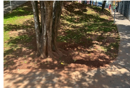
FG 1185 E T Jard ObrCiv - Deslizamento de terra - Foto A2
