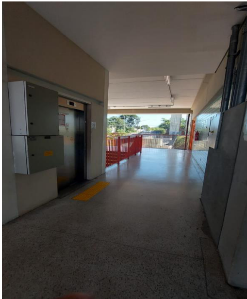
Foto 26 Elevador 5: Vista do corredor, sem CFTV
