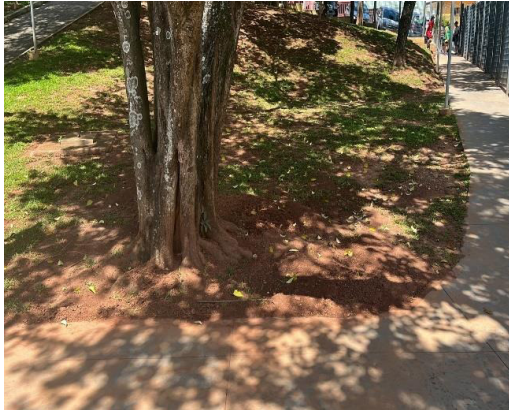
FG 1185 E T Jard ObrCiv - Deslizamento de terra - CEU FG - Foto A2
