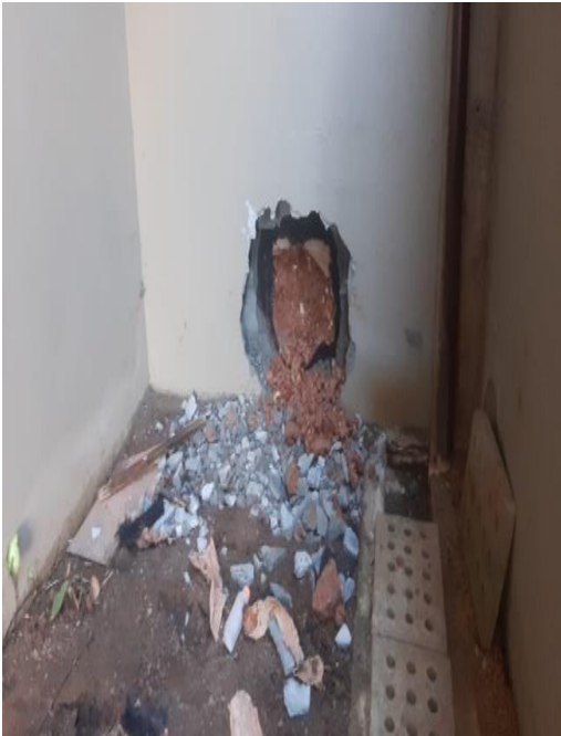
Foto 7: Jardim, abertura para acesso ao porão e retirada do material do talude escavado
