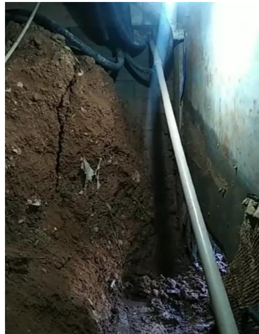
Foto 12: Vista do talude que está sendo escavado em direção a tubulação com vazamento
