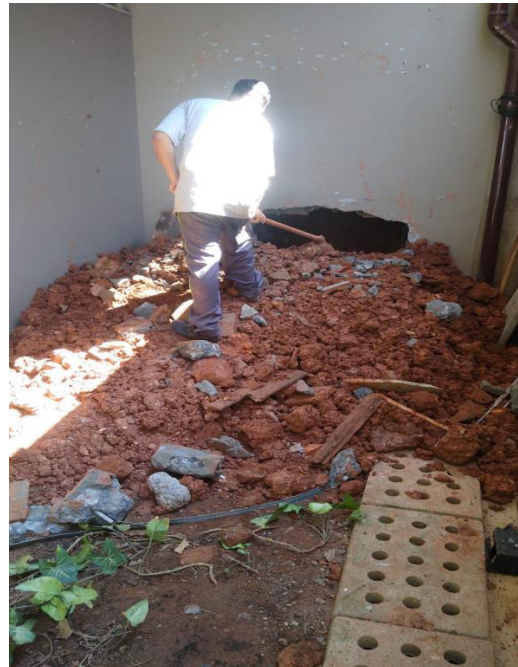
Foto 16: Remoção do entulho escavado
