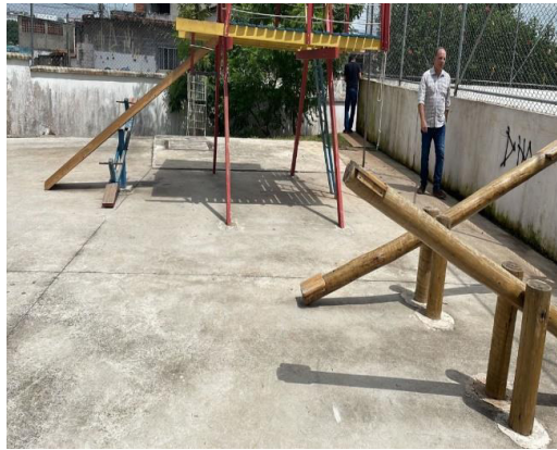
O Piso do playground é inadequado, deveria ser emborrachado.
