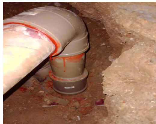
Tubulação reparada com conexões novas e ramal novo
