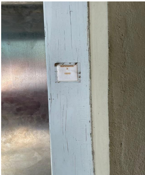
Foto 9 Elevador 3 CEMEI – Elevador externo com infiltração por deficiência de impermeabilização da laje e paredes
