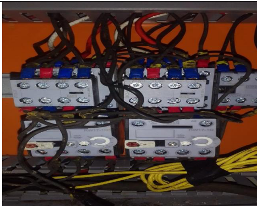
SM 1301 E T Pisc Elétr - Reparo Bomba - Contator e Relê Térmico - Foto A1
