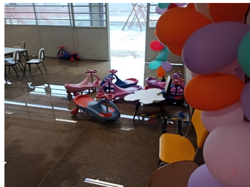
JB 1278 Td G Vários ObrCiv - Alagamento de vários ambientes devido forte chuva - Foto A2
