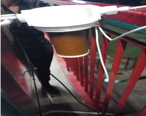
JB 1458 Td G Vários Hidr - Bebedouros saindo água com barro - Foto A4
