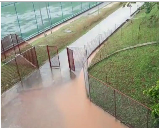
JB 1278 Td G Vários ObrCiv - Alagamento de vários ambientes devido forte chuva - Vídeo A2
