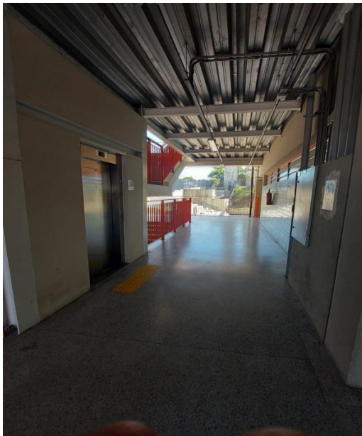
Foto 24 Elevador 5: Vista do corredor, sem CFTV
