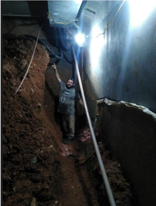
Foto 13: Vista do talude que está sendo escavado em direção a tubulação com vazamento. Pode-se ver o tamanho do talude e seu volume.
