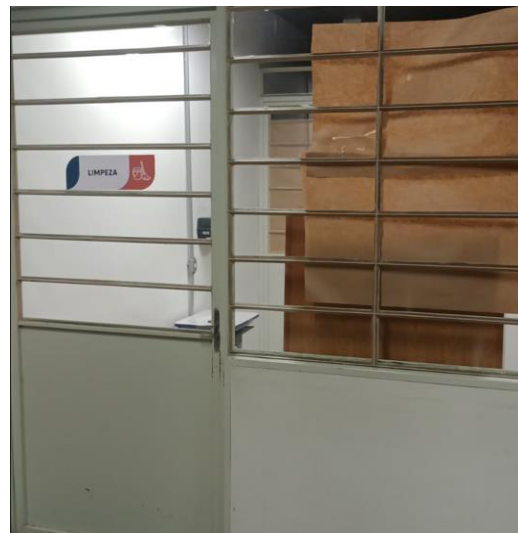
Foto 4: Sala da Limpeza, localização da tubulação com vazamento
