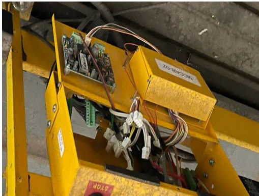
Foto 8 Elevador 2: Cabine do elevador sem as placas de comando
