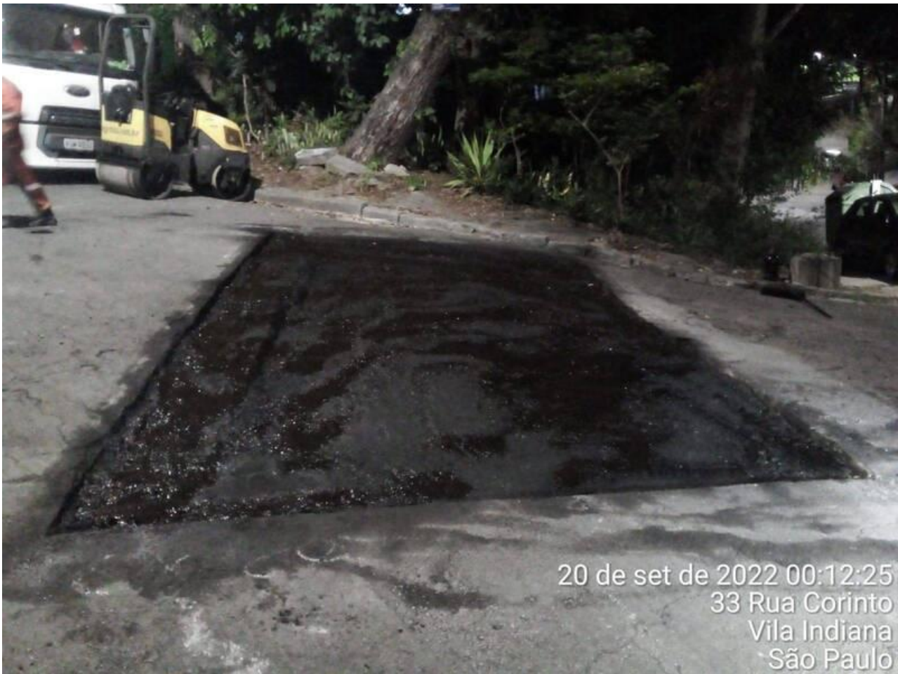
24 | COMPACTAÇÃO: Item de OS APLICAÇÃO DE MASSA Origem: 6291546 - (Foto Capturada Em: 30/09/22 14:35, Por: mxintadm)
