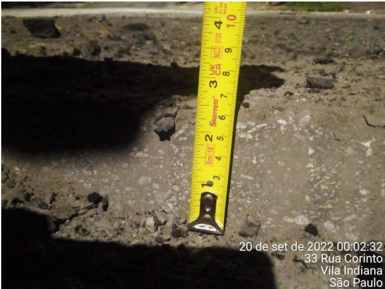
29 | ACABAMENTO → IRRE. DA VIA (CAIXA PRONTA): Item de OS APLICAÇÃO DE MASSA Origem: 6291546 - (Foto Capturada Em: 30/09/22 14:35, Por: mxintadm)
