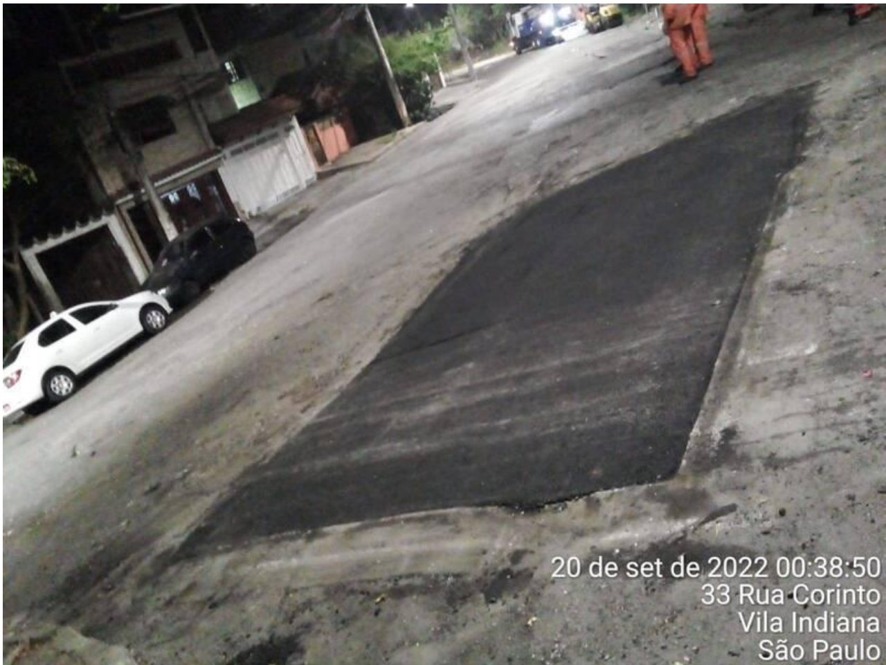
21 | ACABAMENTO: Item de OS APLICAÇÃO DE MASSA Origem: 6291546 - (Foto Capturada Em: 30/09/22 14:35, Por: mxintadm)
