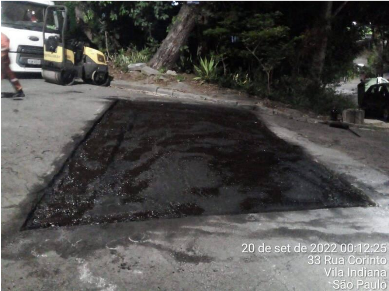
13 | COMPACTAÇÃO: Item de OS APLICAÇÃO DE MASSA Origem: 6291546 - (Foto Capturada Em: 21/09/22 19:06, Por: mxintadm)
