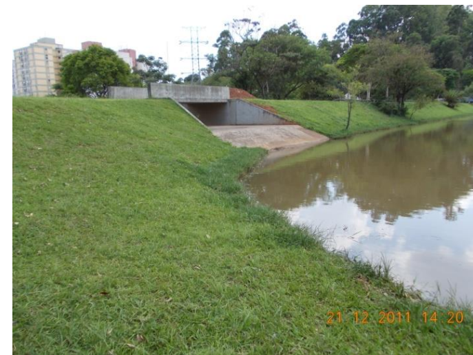
Vertedor do Lago do Parque Cidade de Toronto Lago com armazenamento
