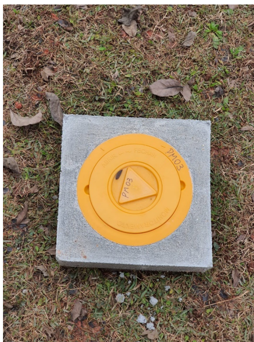
Foto 10 – Poço de Monitoramento 03
