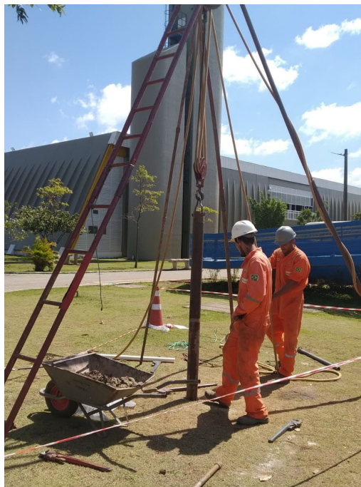
Foto 29 – Perfuração do Poço de Monitoramento 10
