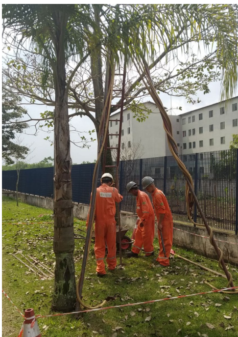
Foto 7 – Perfuração do Poço de Monitoramento 03
