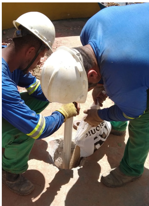
Foto 16 – Aplicação do pré-filtro no Poço de Monitoramento 05
