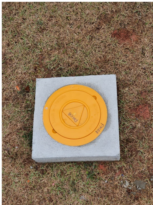
Foto 23 – Poço de Monitoramento 08
