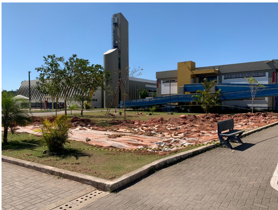
Foto 9 – Vista frontal do prédio da gestão
