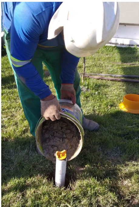
Foto 27 – Aplicação da bentonita no Poço de Monitoramento 09
