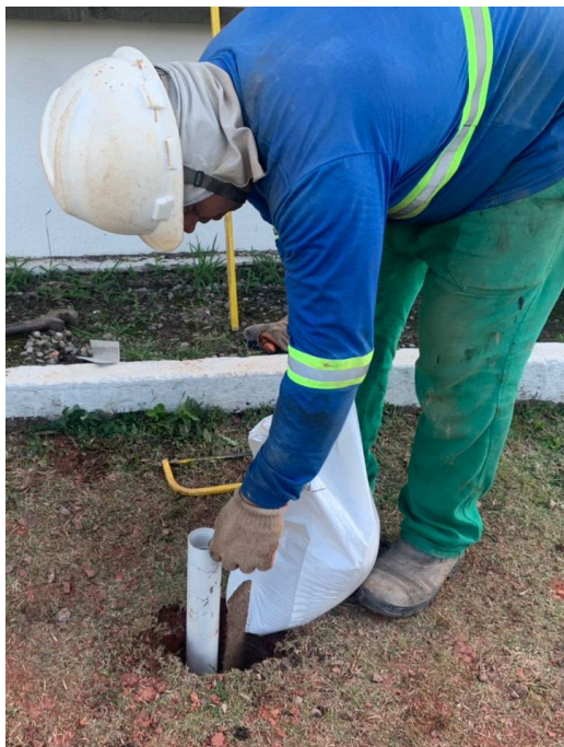
Foto 33 – Aplicação do pré-filtro no Poço de Monitoramento 12
