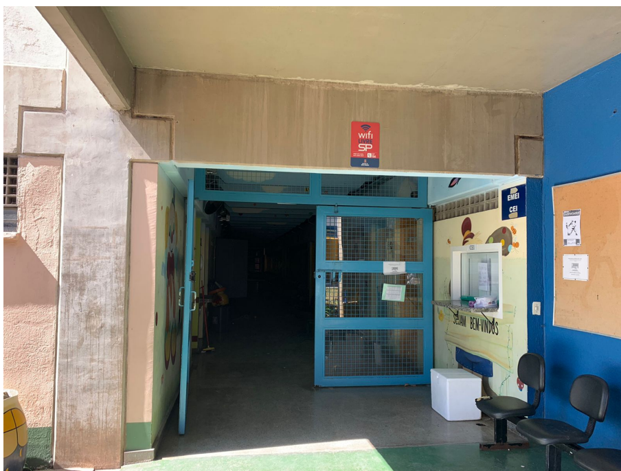
Foto 10 – Prédio EMEI, localizado à leste
