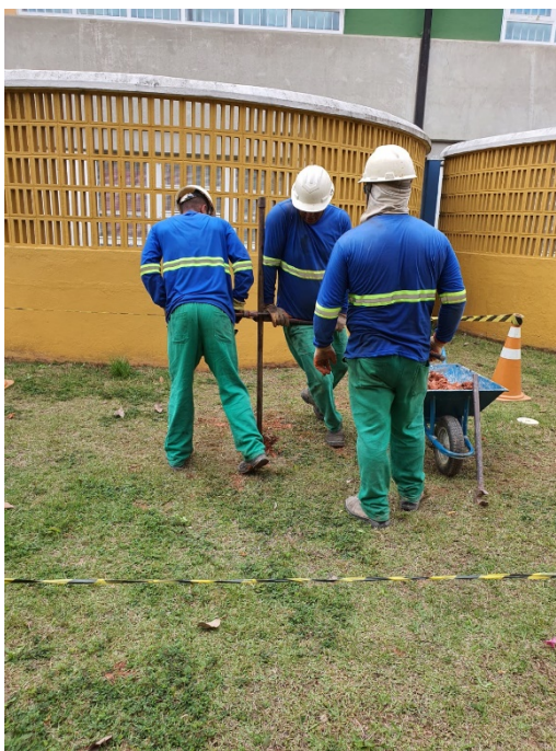
Foto 11 – Perfuração do Poço de Monitoramento 04
