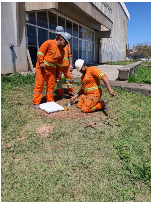
Foto 31 – Aplicação do pré-filtro no Poço de Monitoramento 11
