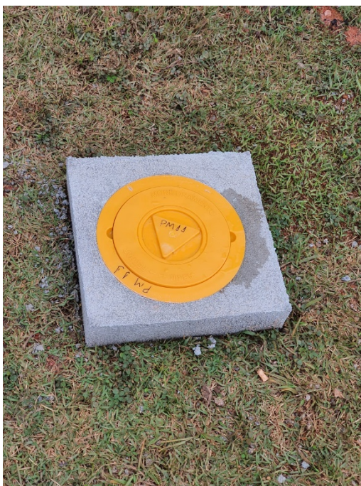
Foto 32 – Poço de Monitoramento 11
