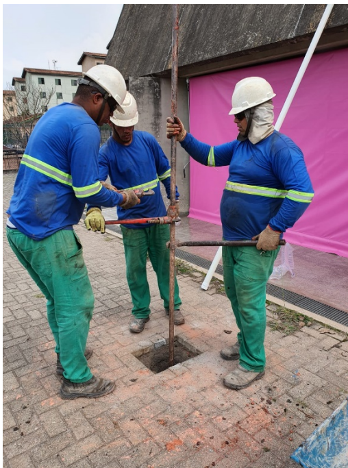
Foto 19 – Perfuração do Poço de Monitoramento 06
