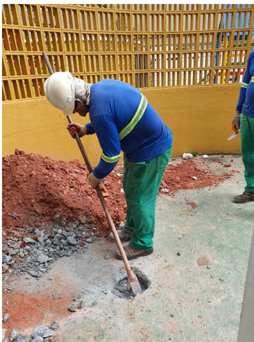
Foto 14 – Perfuração do Poço de Monitoramento 05
