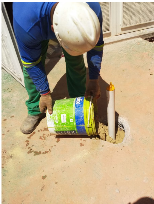
Foto 17 – Aplicação da bentonita no Poço de Monitoramento 05
