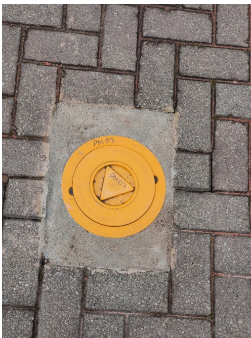
Foto 22 – Poço de Monitoramento 07
