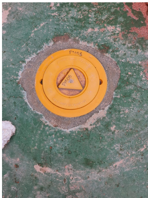
Foto 18 – Poço de Monitoramento 05
