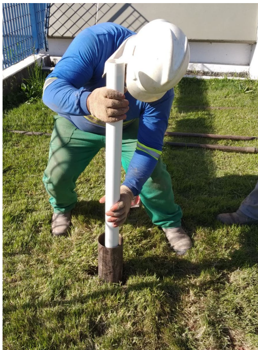
Foto 25 – Instalação do tubo no Poço de Monitoramento 09
