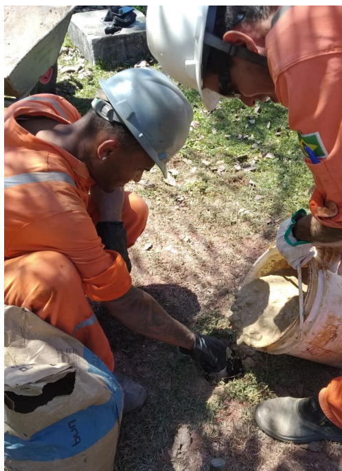
Foto 9 – Aplicação da bentonita no Poço de Monitoramento 03
