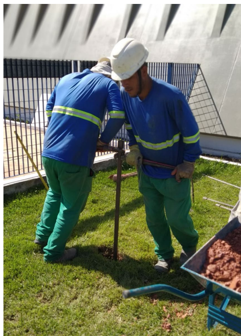
Foto 24 – Perfuração do Poço de Monitoramento 09
