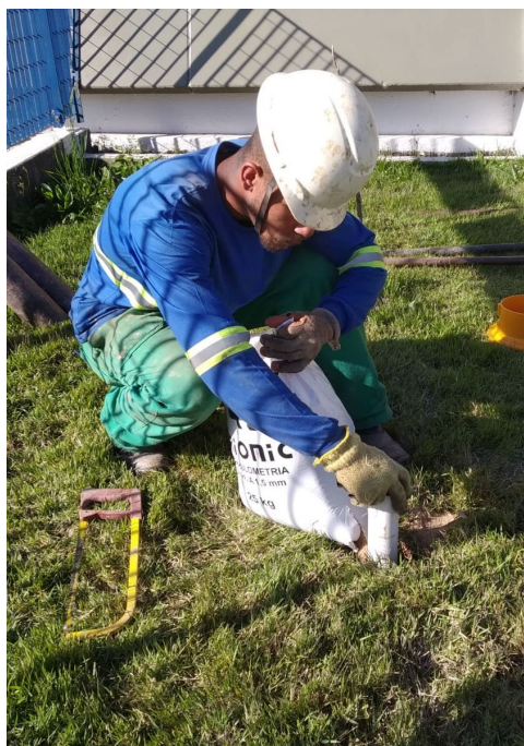
Foto 26 – Aplicação do pré-filtro no Poço de Monitoramento 09
