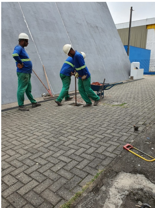
Foto 21 – Perfuração do Poço de Monitoramento 07
