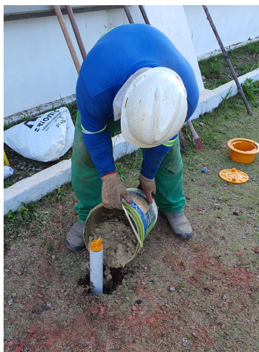
Foto 34 – Aplicação da bentonita no Poço de Monitoramento 12
