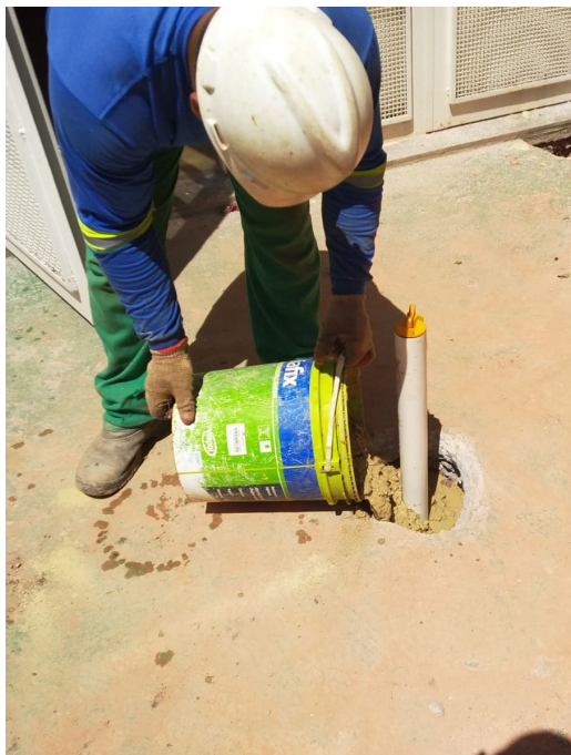
Foto 17 – Aplicação da bentonita no Poço de Monitoramento 05
