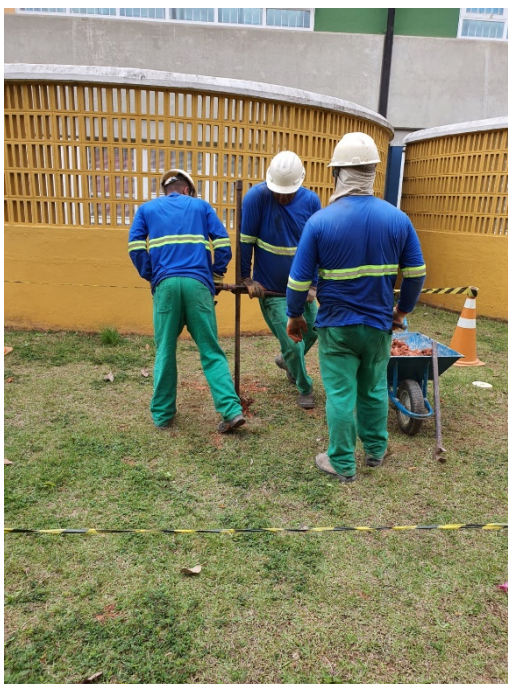
Foto 11 – Perfuração do Poço de Monitoramento 04
