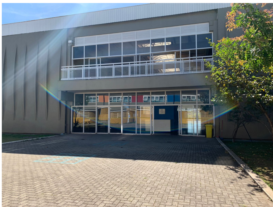
Foto 14 – Prédio à oeste da área em estudo
