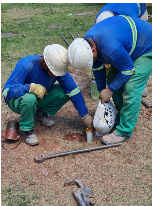
Foto 12 – Aplicação do pré-filtro no Poço de Monitoramento 04
