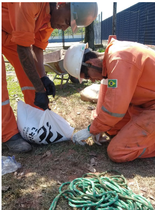
Foto 8 – Aplicação do pré-filtro no Poço de Monitoramento 03
