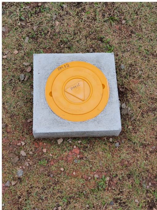
Foto 35 – Poço de Monitoramento 12
