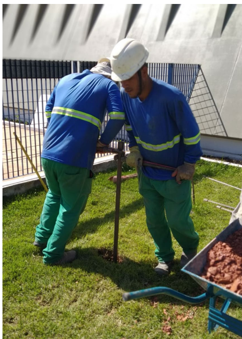
Foto 24 – Perfuração do Poço de Monitoramento 09
