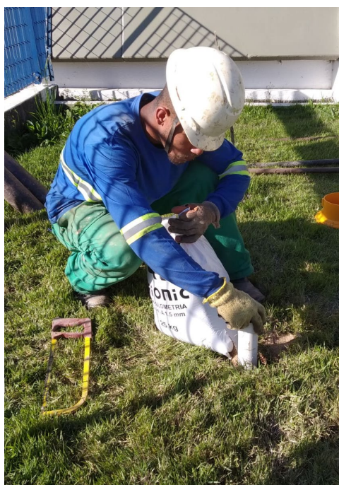
Foto 26 – Aplicação do pré-filtro no Poço de Monitoramento 09
