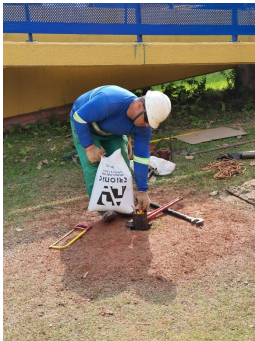
Foto 5 – Aplicação do pré-filtro no Poço de Monitoramento 02
