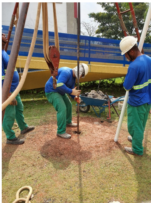
Foto 3 – Perfuração do Poço de Monitoramento 02
