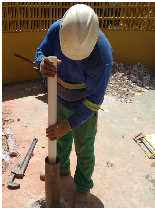
Foto 15 – Instalação do tubo no Poço de Monitoramento 05
