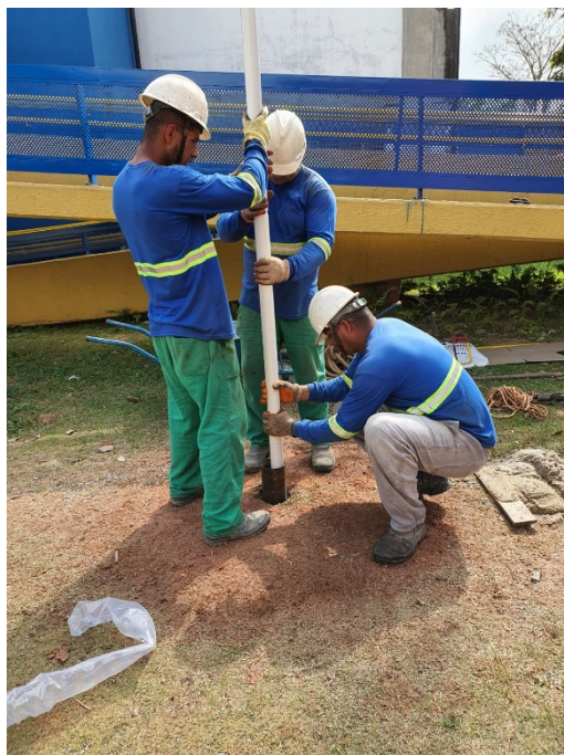
Foto 4 – Instalação do tubo no Poço de Monitoramento 02
