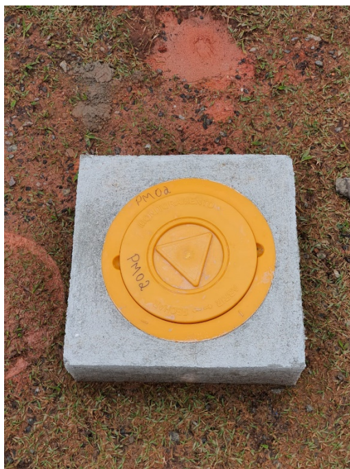
Foto 6 – Poço de Monitoramento 02
