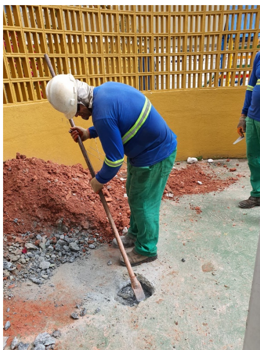
Foto 14 – Perfuração do Poço de Monitoramento 05
