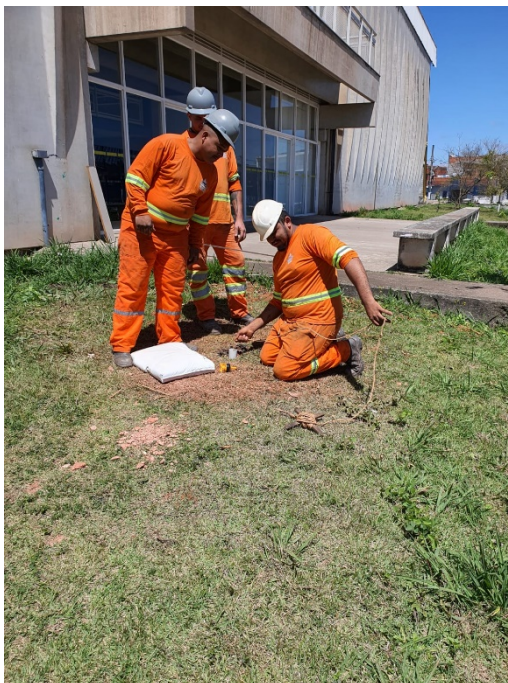
Foto 31 – Aplicação do pré-filtro no Poço de Monitoramento 11
