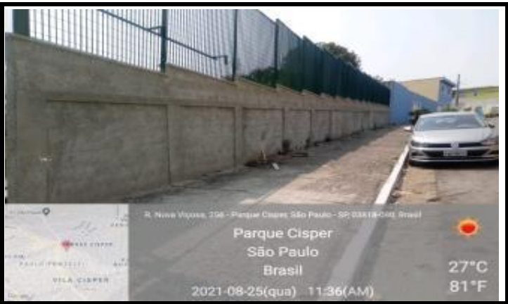
Rua Nova Viçosa Nº 301 (muro do Estacionamento)
