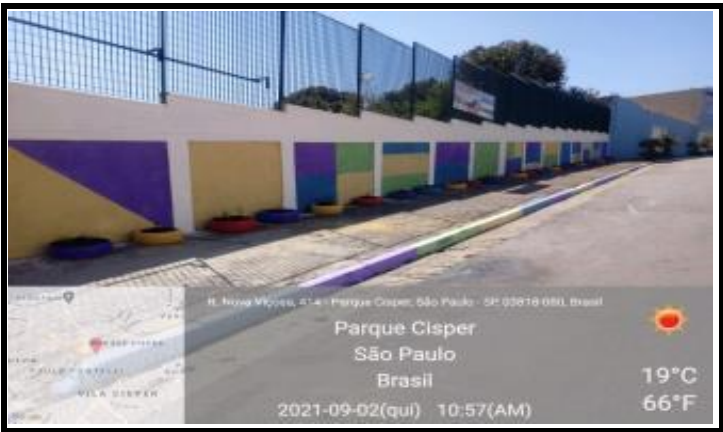
Rua Nova Viçosa Nº 301 (muro do Estacionamento)
