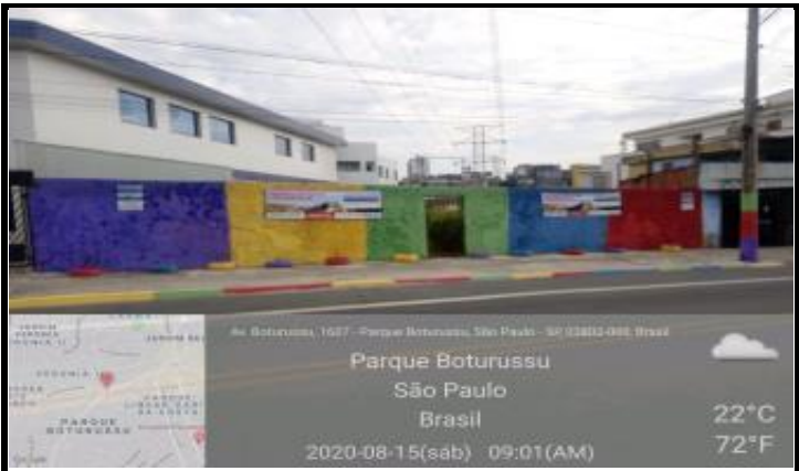
Av. Boturussu, 1607 (Torre Eletrica)
