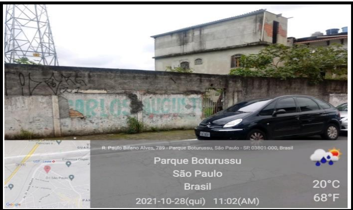
Rua Paulo Bifano Alves, 789 (Muro da Enel)
