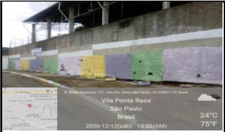
Rua Bento Espinosa, (Muro do fundo da Escola)
