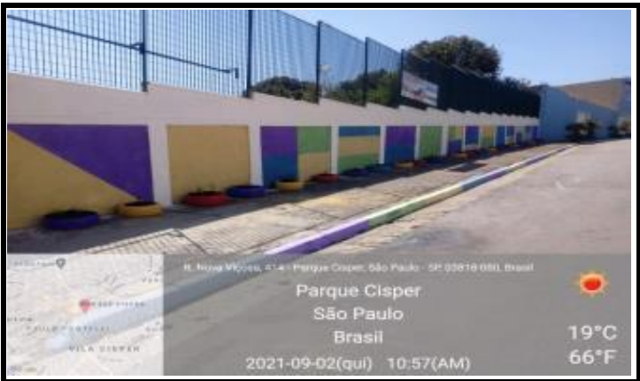
Rua Nova Viçosa Nº 301 (muro do Estacionamento)
