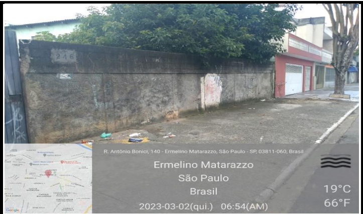
Rua Antonio Bonici, 273 (Muro da Enel) (2º Lado)
