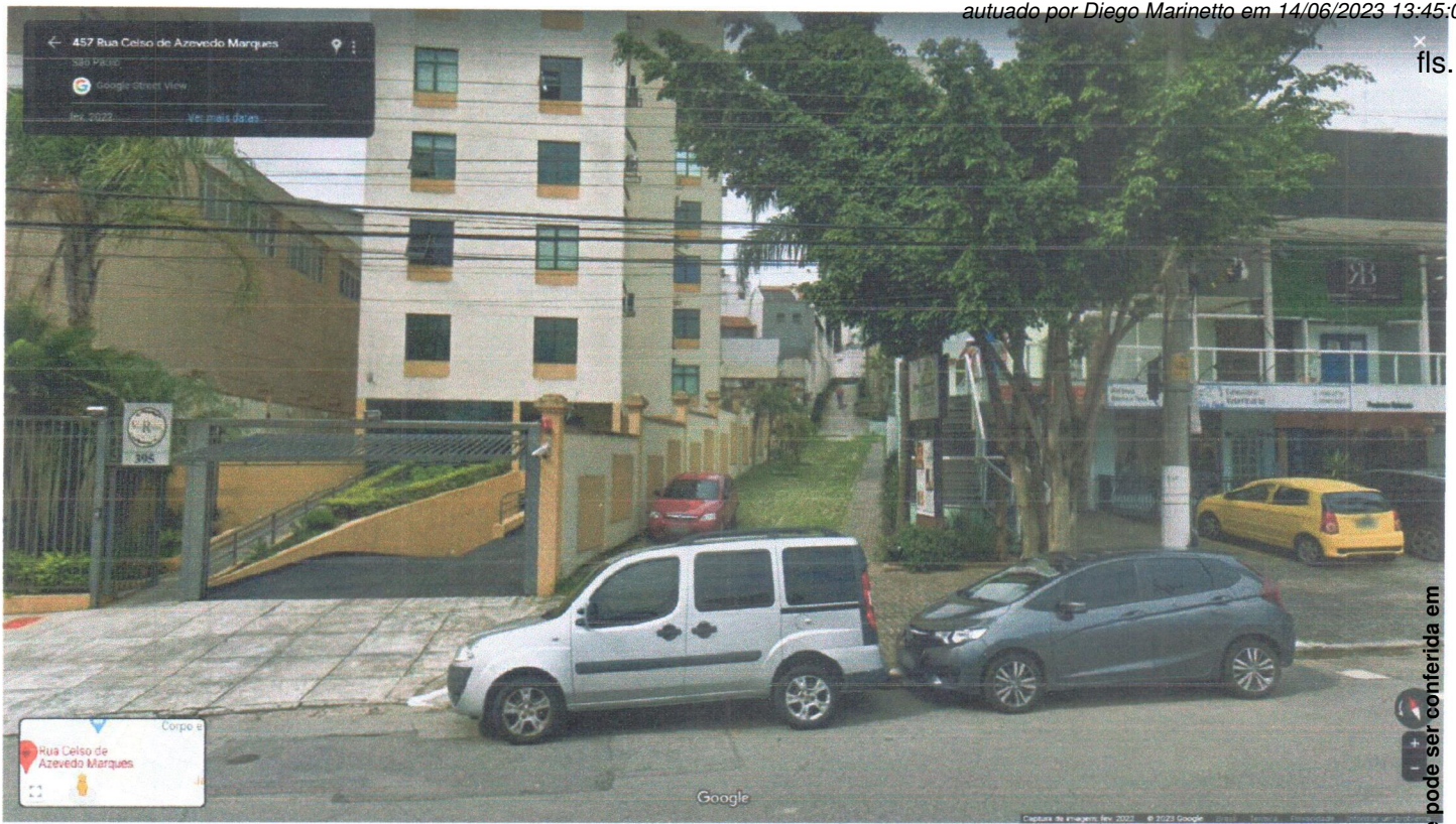
Vista da Vela sem denominação pela Rua Celso de Azevedo Marques, entre n°s 395 e 423.
