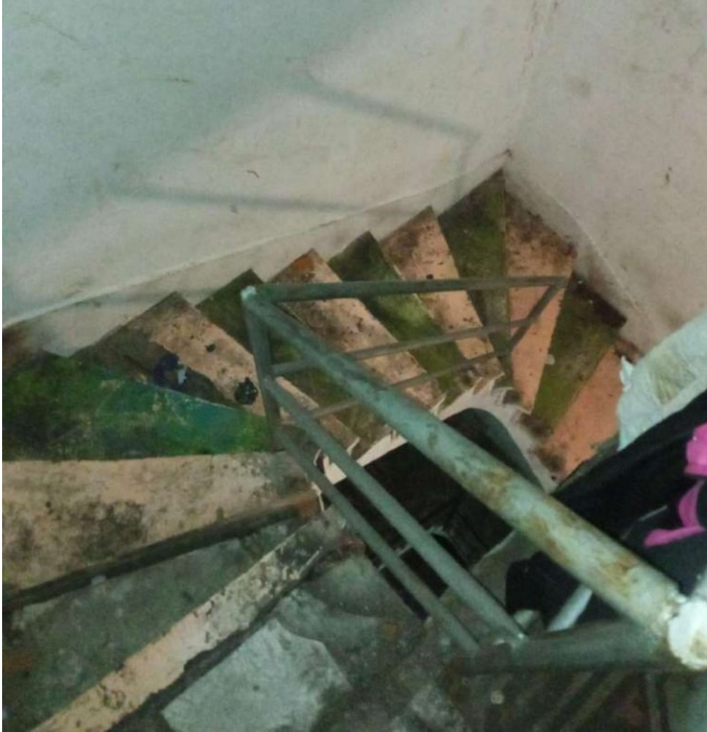
Figura 15: vista superior da escada com guarda corpo metálico instalado.
