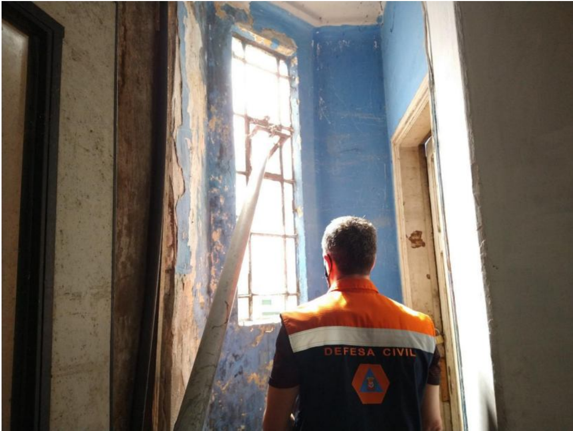
Foto 3. Padrão construtivo: observar as habitações em alvenaria.
