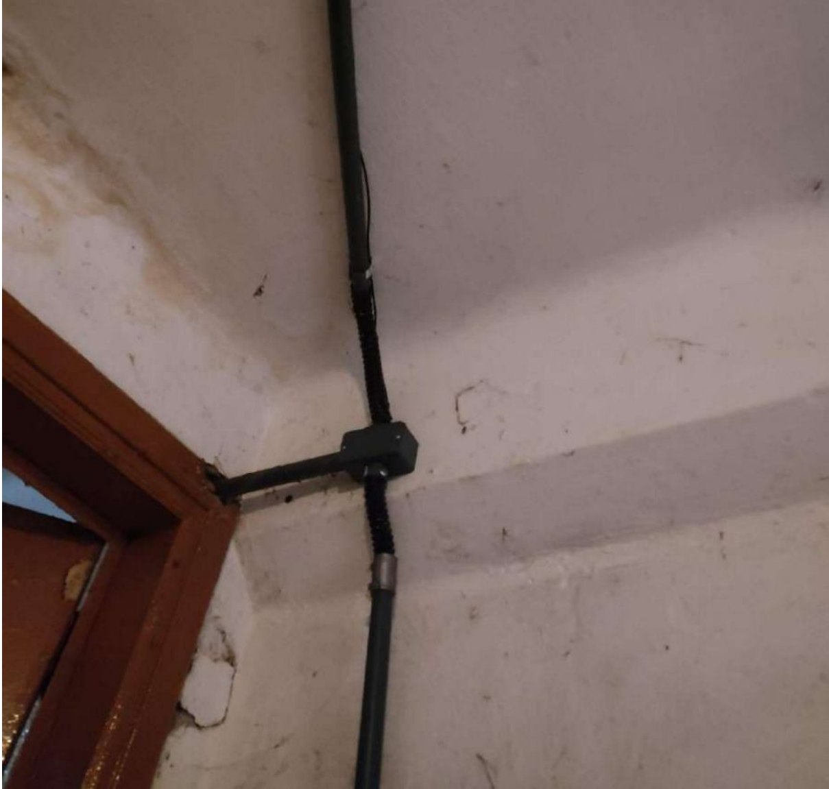
Figura 12: entrada da tubulação elétrica em uma das unidades habitacionais.
