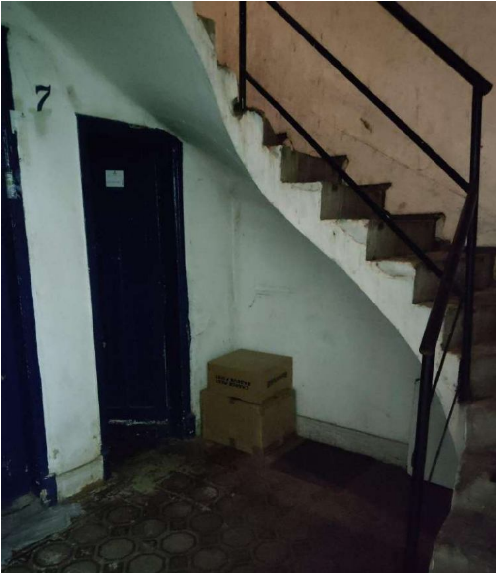
Figura 8: escada do primeiro para o segundo pavimento, com guarda corpo metálico instalado.
