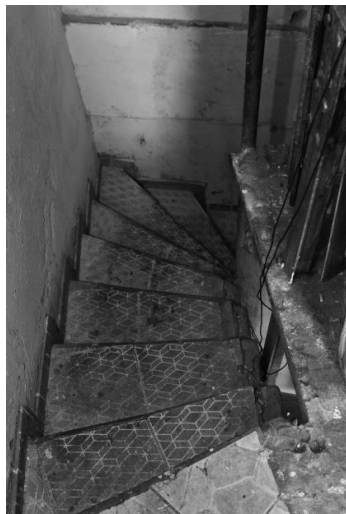
FOTO 5 - Vista da escada
