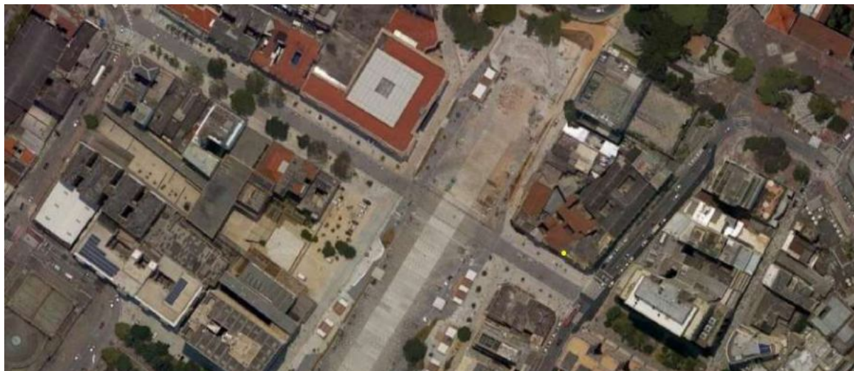
Figura 1: localização da edificação, junto ao Vale do Anhangabaú. Fonte: imagem de satélite do Google Maps.
