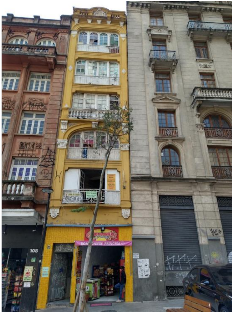
Foto 1. Imóvel vistoriado, localizado na Av.São João, n°104.
