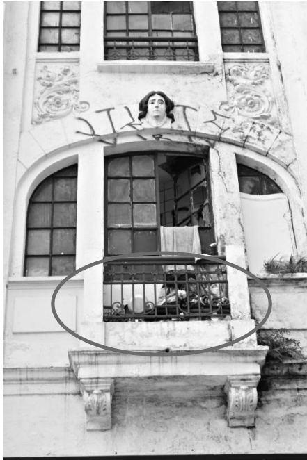
FOTO 7 – Acúmulo de lixo em sacada
