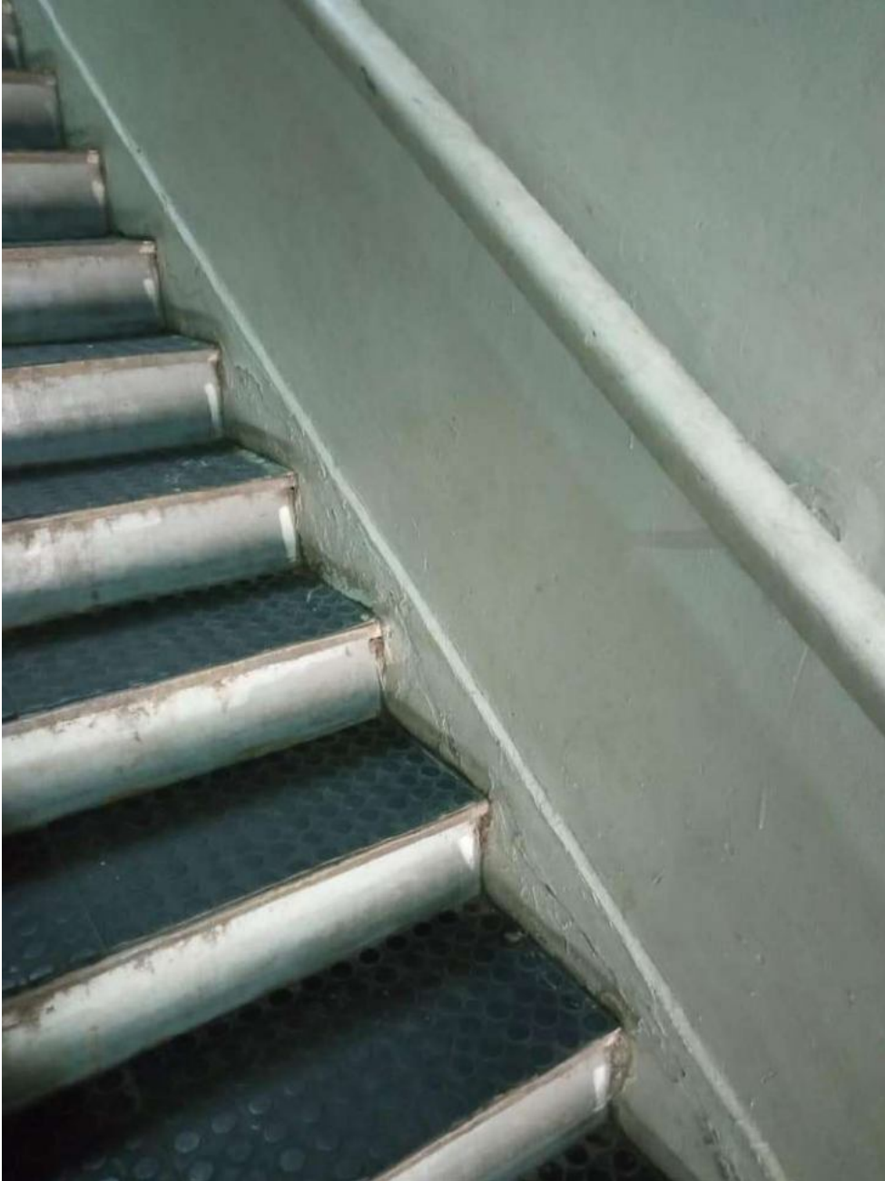
Figura 16: escada que liga o térreo ao primeiro pavimento, com corrimão e piso emborrachado instalado.
