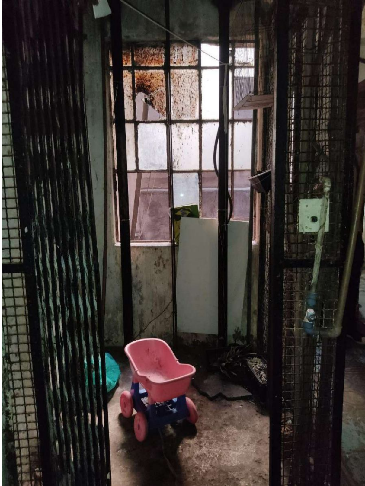
Figura 13: vão do elevador, aberto e com alguns materiais remanescentes.
