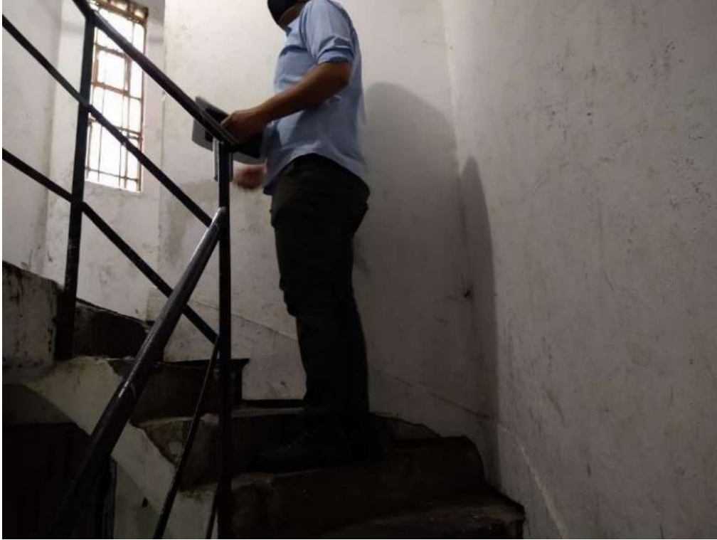
Figura 5:: guarda corpo metálico instalado entre o segundo e quinto pavimento.
