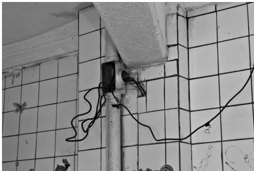
FOTO 3 - Exposição da fiação e emendas
