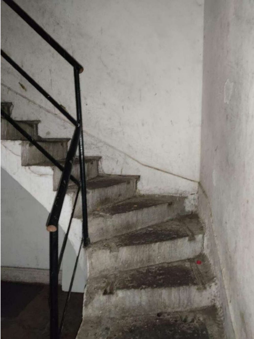
Figura 14: escada do primeiro para o segundo pavimento, com guarda corpo metálico instalado.
