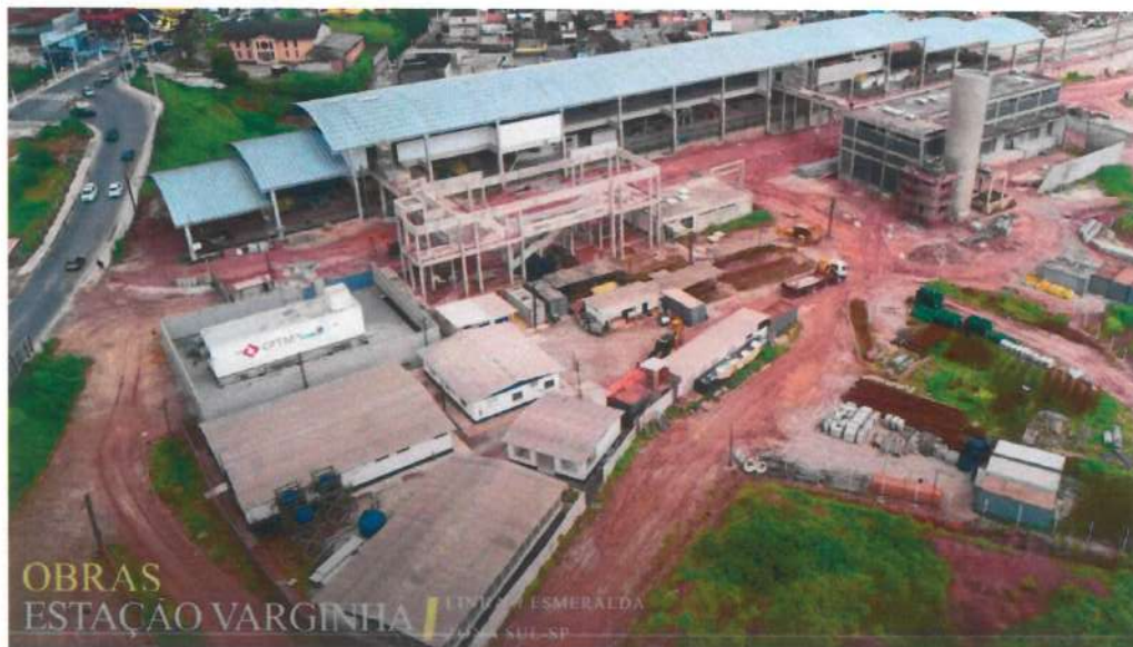
Obras da estação e terminal de ônibus Variginha da Linha 9 - Esmeralda em 2022
