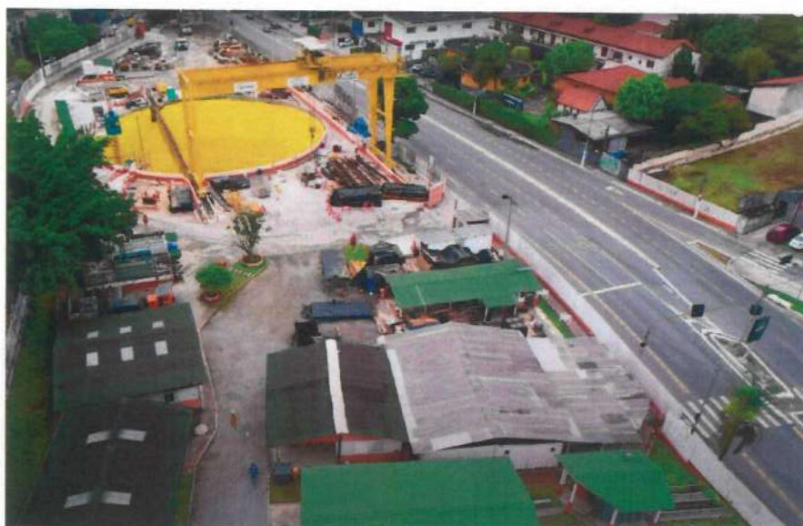
Obras da estação e terminal de ônibus João Paulo I da Linha 6 - Laranja em 2022
