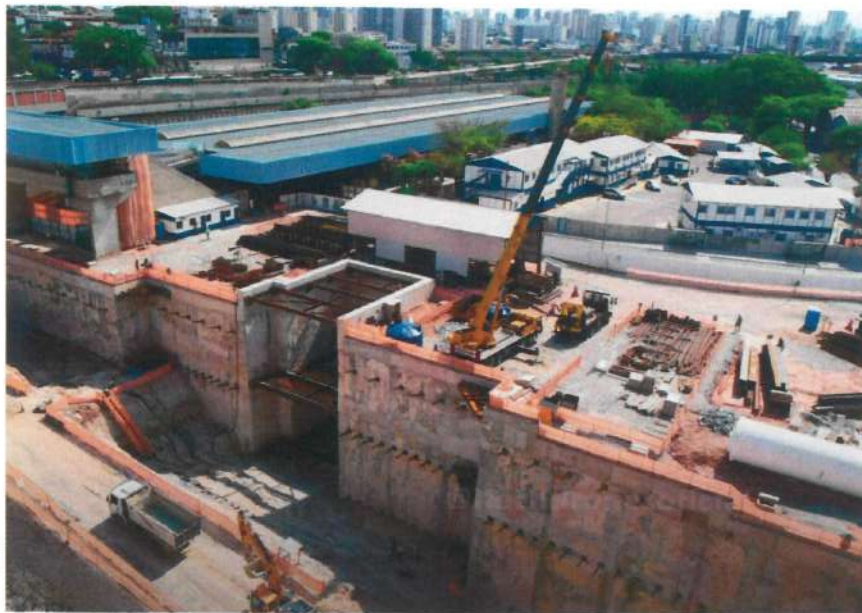
Estação Penha da Linha 2 - Verde: obras de integração com a estação e terminal de ônibus em 2022
