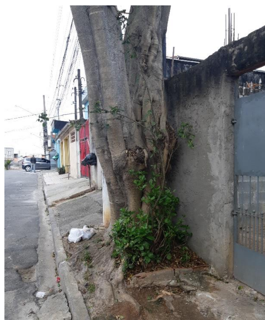
Figura 2 – Detalhe do tronco do espécime arbóreo aparentemente sem danos, presença de raízes naturalmente expostas; descartado risco de queda da árvore, encontrando-se estável.
