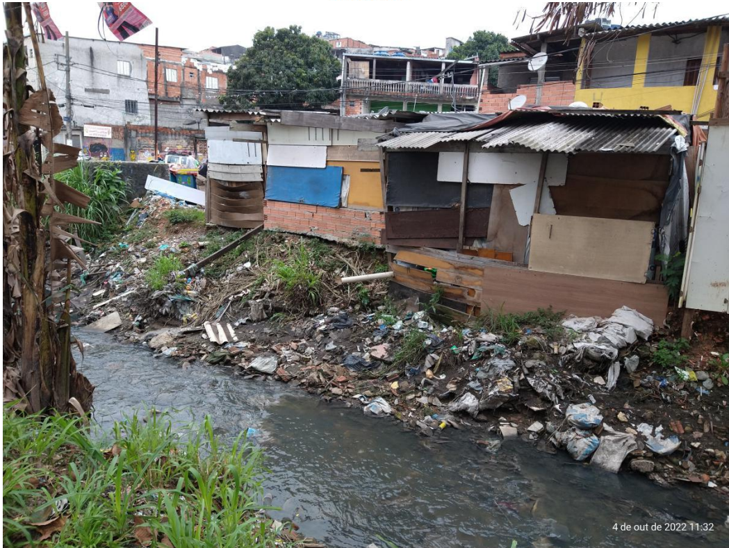
Foto 01 – Aspecto geral das edificações localizadas na rua José de Maistre, altura do número 456.
