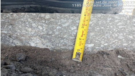
10 | PROFUNDIDADE → RASA: Item de OS APLICAÇÃO DE MASSA 6229187 (03/09/22 07:11 MXINTADM)
