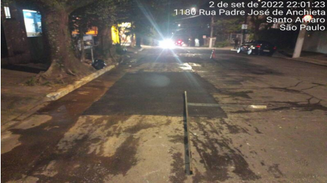
11 | ACABAMENTO → NÍVEL C/RÉGUA (CAIXA PRONTA): Item de OS APLICAÇÃO DE MASSA 6229187 (03/09/22 07:11 MXINTADM)
