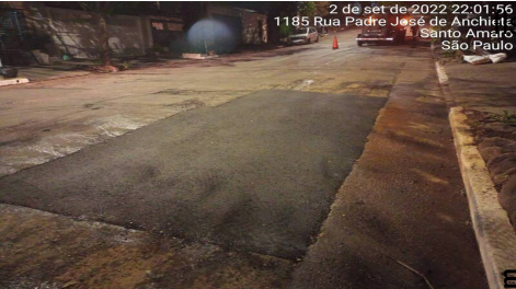
9 | APLICAÇÃO → EMULSÃO: Item de OS APLICAÇÃO DE MASSA 6229187 (03/09/22 07:11 MXINTADM)
