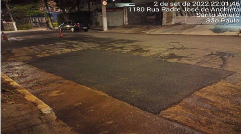
11 | ACABAMENTO → NÍVEL C/RÉGUA (CAIXA PRONTA): Item de OS APLICAÇÃO DE MASSA 6229187 (03/09/22 07:11 MXINTADM)
