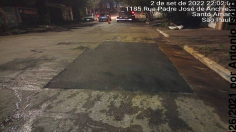
12 | ACABAMENTO → IRRE. DA VIA (CAIXA PRONTA): Item de OS APLICAÇÃO DE MASSA 6229187 (03/09/22 07:11 MXINTADM)
