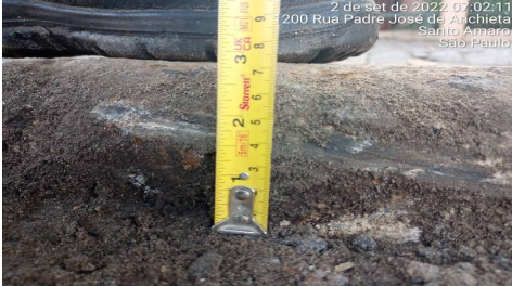
10 | PROFUNDIDADE → RASA: Item de OS APLICAÇÃO DE MASSA 6229187 (03/09/22 07:11 MXINTADM)
