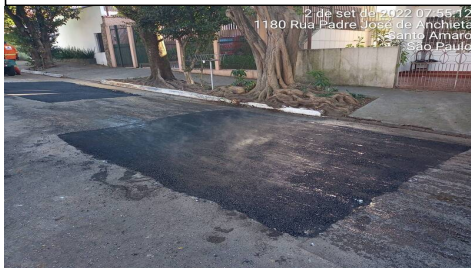
11 | ACABAMENTO → IRRE. DA VIA (CAIXA PRONTA): Item de OS APLICAÇÃO DE MASSA 6247429 (02/09/22 09:01 MXINTADM)
