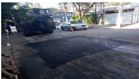
11 | ACABAMENTO → IRRE. DA VIA (CAIXA PRONTA): Item de OS APLICAÇÃO DE MASSA 6247429 (02/09/22 09:01 MXINTADM)
