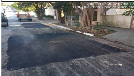
10 | ACABAMENTO → IRRE. DA VIA (CAIXA PRONTA): Item de OS APLICAÇÃO DE MASSA 6247429 (02/09/22 09:01 MXINTADM)
