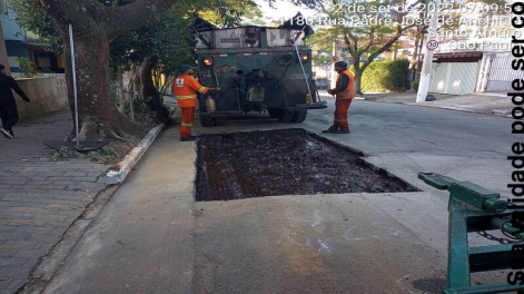
12 | ACABAMENTO → IRRE. DA VIA (CAIXA PRONTA): Item de OS APLICAÇÃO DE MASSA 6229187 (03/09/22 07:11 MXINTADM)
