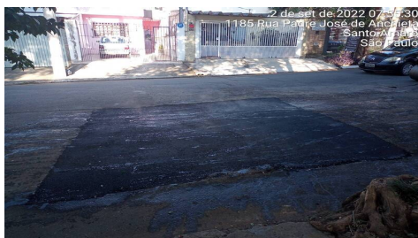
10 | ACABAMENTO → IRRE. DA VIA (CAIXA PRONTA): Item de OS APLICAÇÃO DE MASSA 6247429 (02/09/22 09:01 MXINTADM)
