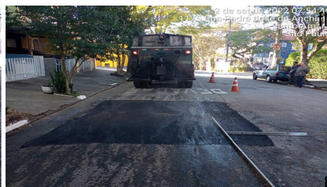
12 | ACABAMENTO → IRRE. DA VIA (CAIXA PRONTA): Item de OS APLICAÇÃO DE MASSA 6247429 (02/09/22 09:01 MXINTADM)
