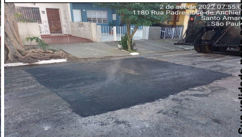
12 | ACABAMENTO → IRRE. DA VIA (CAIXA PRONTA): Item de OS APLICAÇÃO DE MASSA 6247429 (02/09/22 09:01 MXINTADM)
