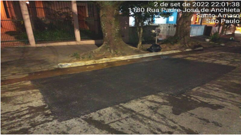
8 | ACABAMENTO → IRRE. DA VIA (CAIXA PRONTA): Item de OS APLICAÇÃO DE MASSA 6229187 (03/09/22 07:11 MXINTADM)
