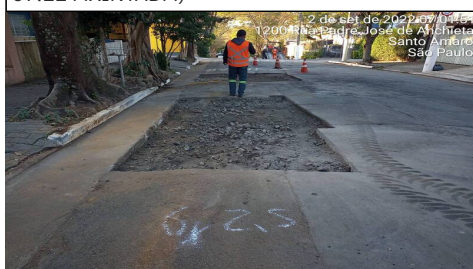
4 | APLICAÇÃO → M.ASFÁLTICA (HASTE): Item de OS APLICAÇÃO DE MASSA 6229187 (03/09/22 07:11 MXINTADM)
