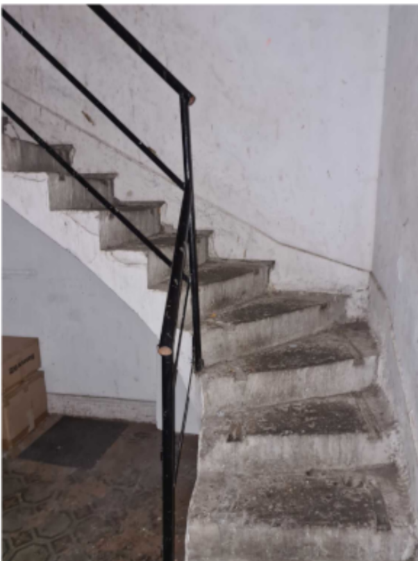
Escada Interna Corremão de um lado
