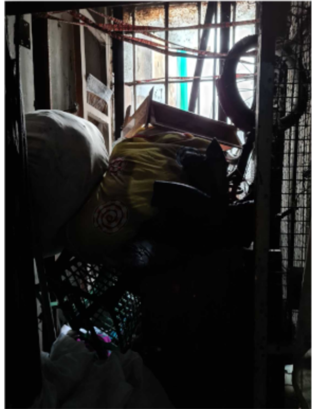
Acúmulo de Lixo no Poço do Elevador
