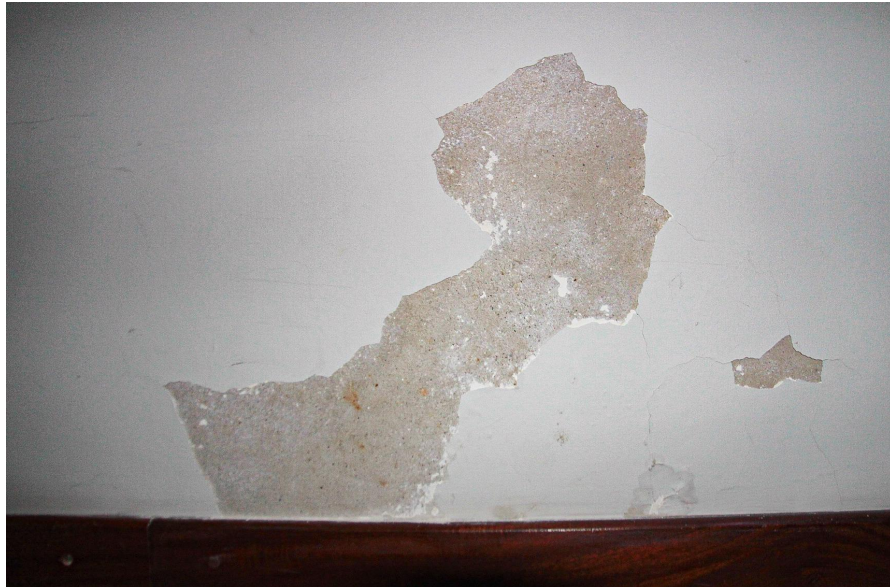
Figura 3: parede descascando
