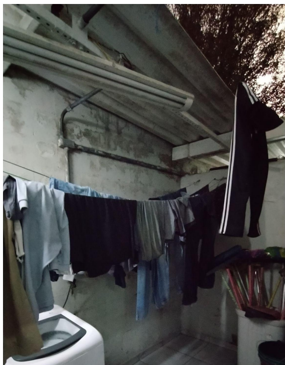
Figura 24: varal e teto semi descoberto
