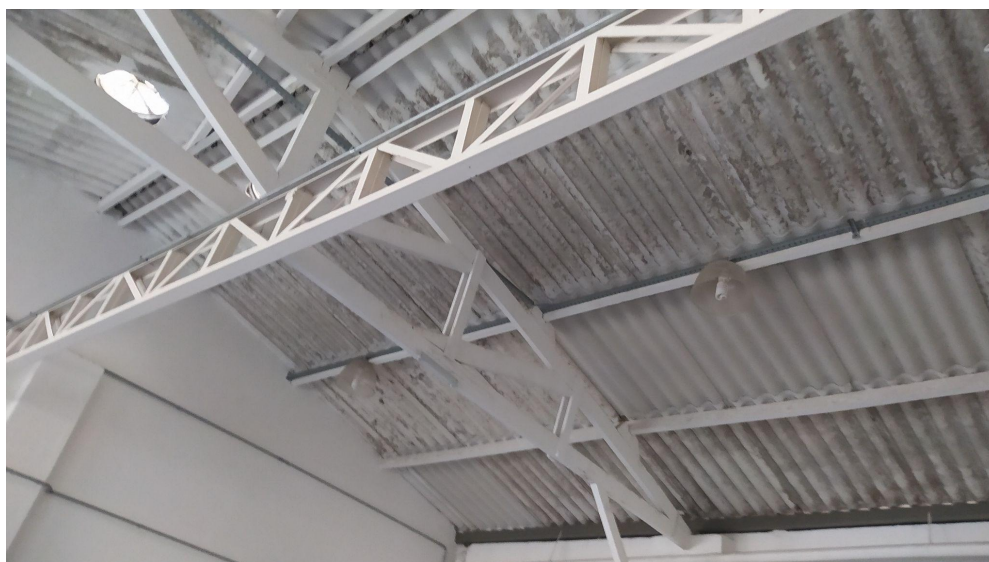
Figura 2: teto do galpão
