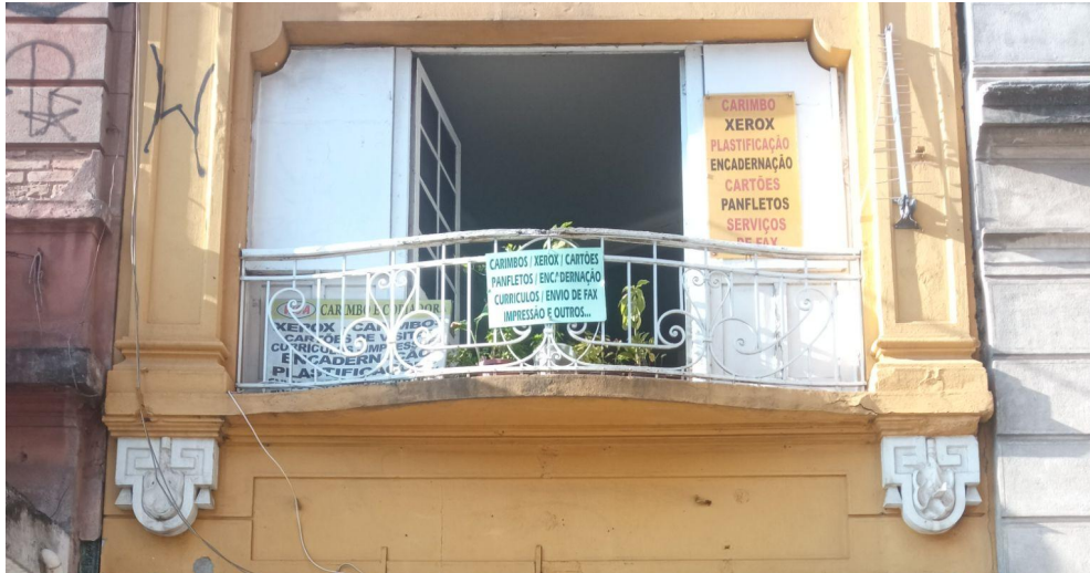
Figura 05: vista externa da janela do primeiro andar - gráfica - na qual é possível verificar a amplitude das janelas da edificação.
