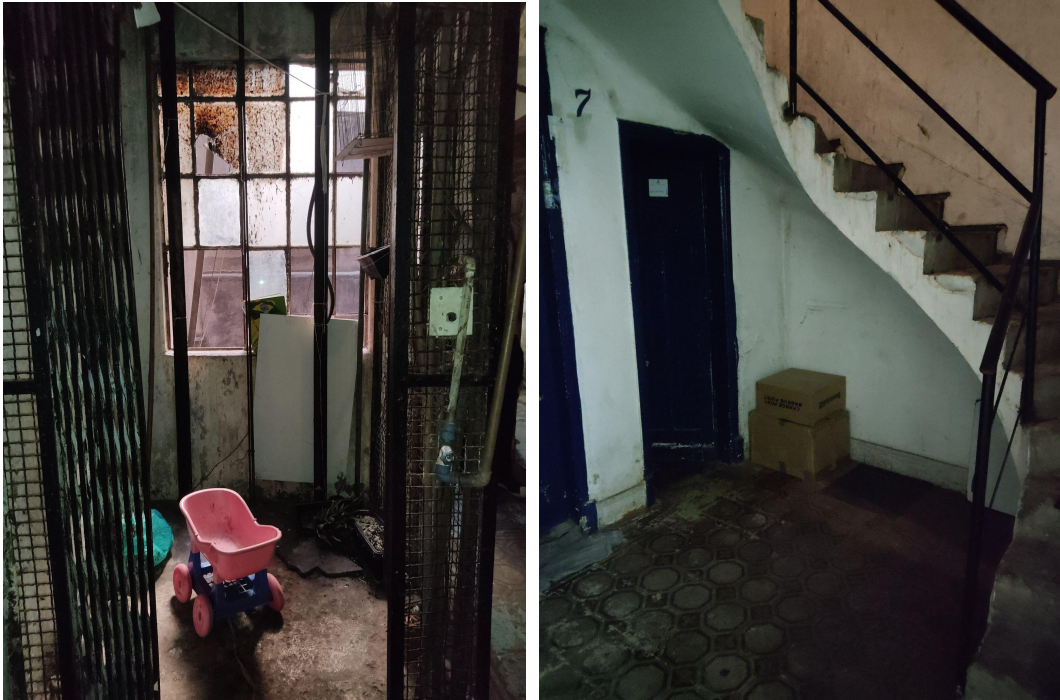
Figuras 06 e 07: vão do elevador com presença de detritos e desimpedida e escada do primeiro para o segundo pavimento, com corrimão instalado em um dos lados.
