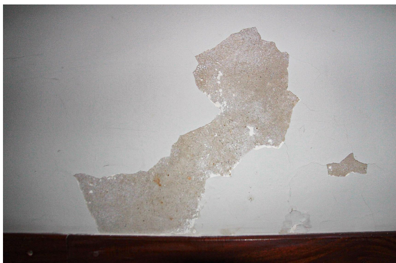
Figura 3: parede descascando
