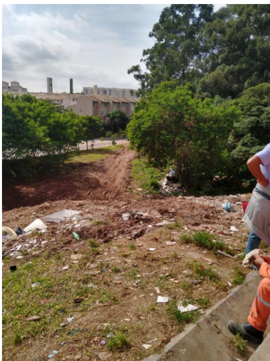
FIGURA 4 –Detalhe da área após a limpeza mecanizada
