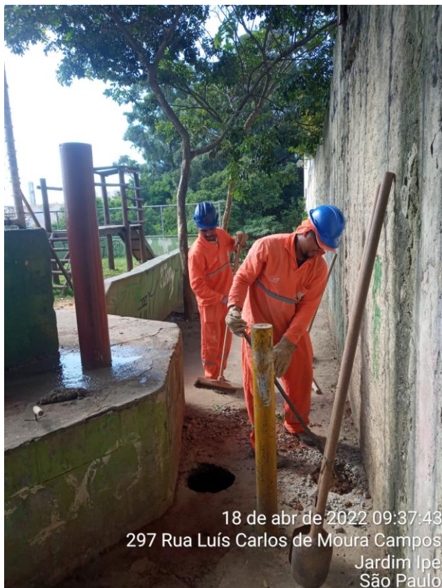
FIGURA 8 – instalação de obstáculos adicionais no local para evitar a entrada com carrinho-de-mão
