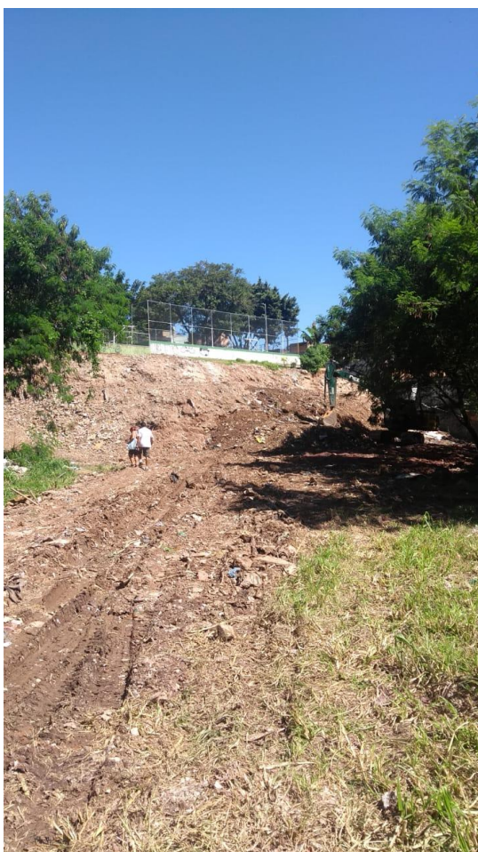
FIGURA 5 – Detalhe da limpeza mecanizada sendo finalizada
