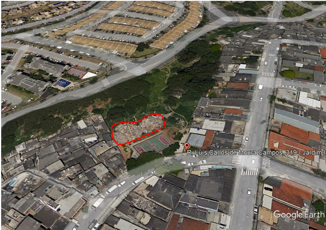
FIGURA 3 – Localização do entulho, delimitado em vermelho
