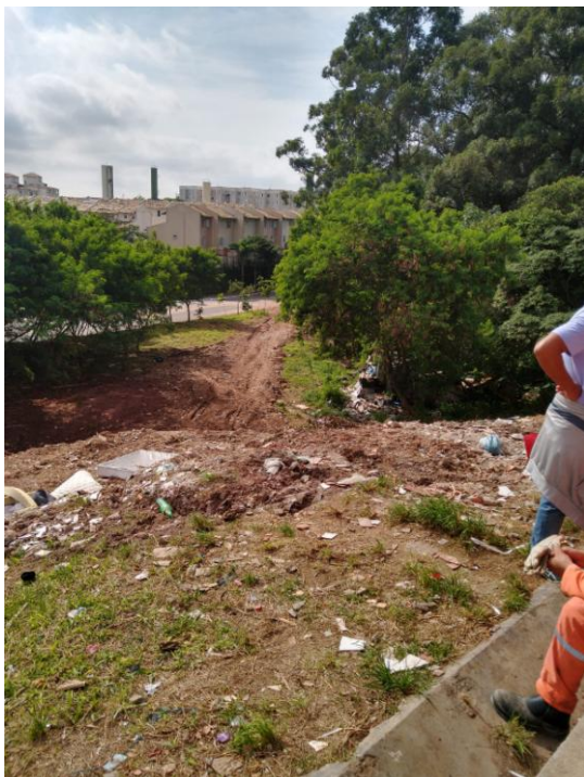
FIGURA 4 –Detalhe da área após a limpeza mecanizada
