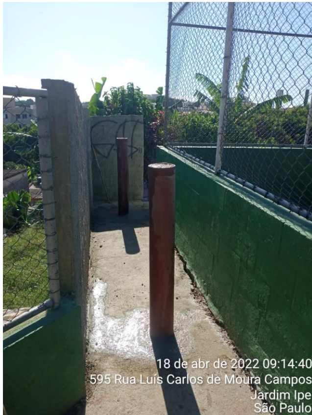
FIGURA 8 - Obstáculo instalado no local para evitar a entrada com carrinho-de-mão
