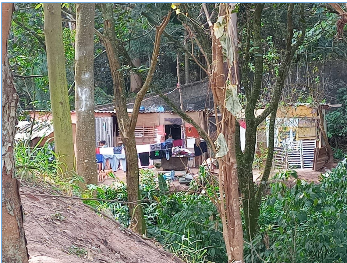
Figura 3. Construções no Parque Horto do Ipê na altura do número 685 da R. Francisco da Cruz Mellão
