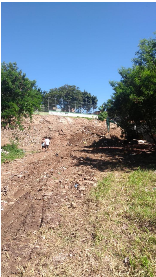
FIGURA 5 – Detalhe da limpeza mecanizada sendo finalizada
