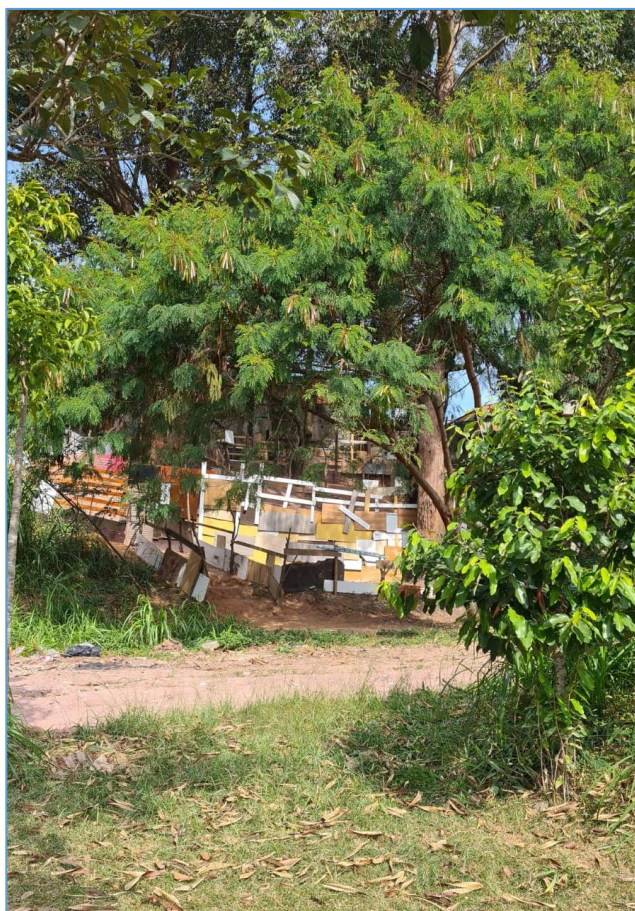
Figura 10. Construção na área do Parque, na altura do número 123
