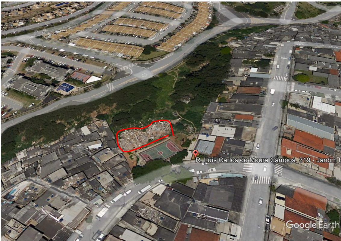
FIGURA 3 – Localização do entulho, delimitado em vermelho
