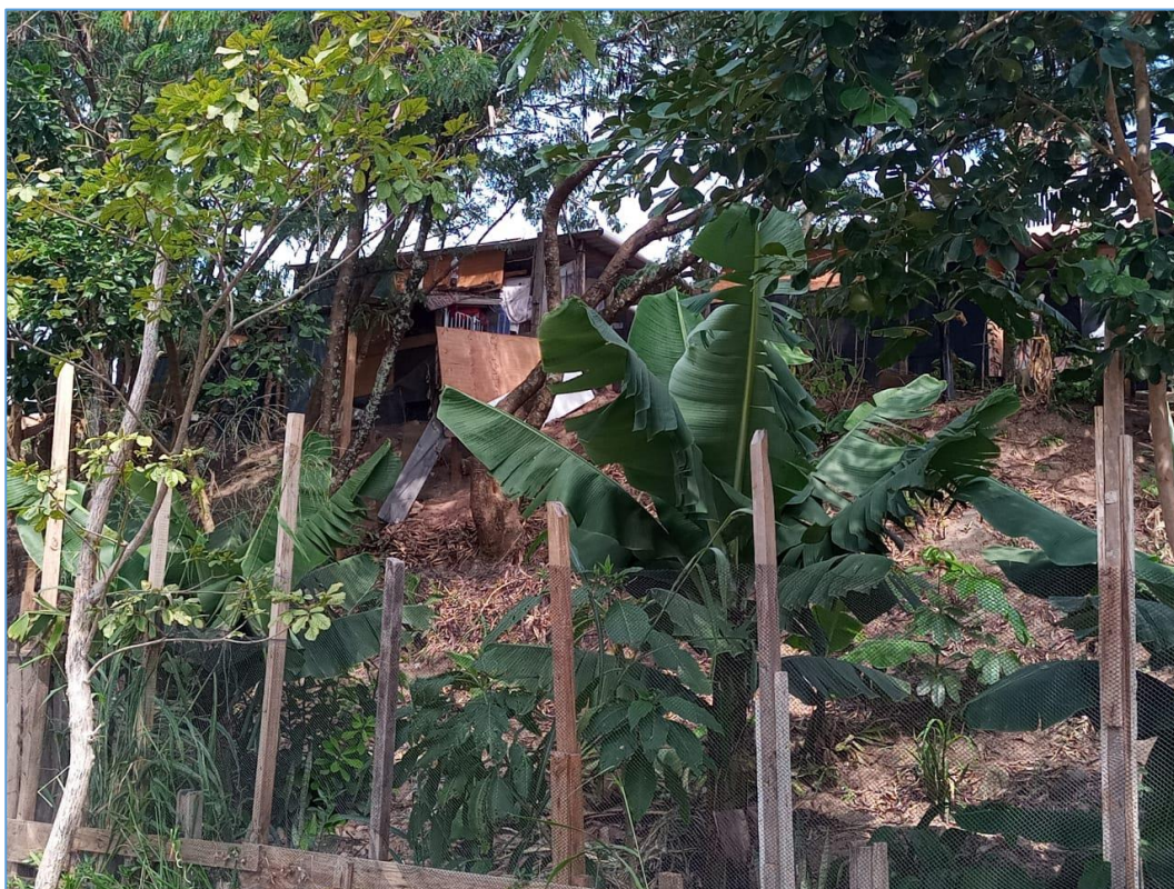
Figura 9. Construção na área do Parque, na altura do número 245
