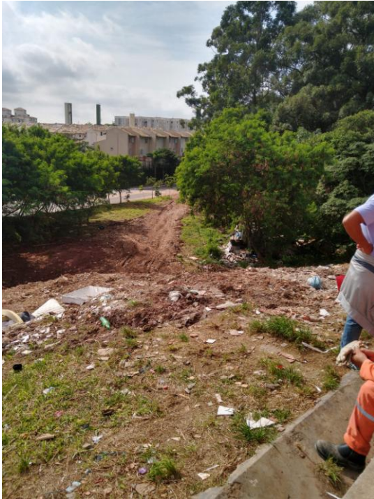
FIGURA 4 –Detalhe da área após a limpeza mecanizada
