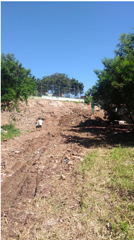
FIGURA 5 – Detalhe da limpeza mecanizada sendo finalizada
