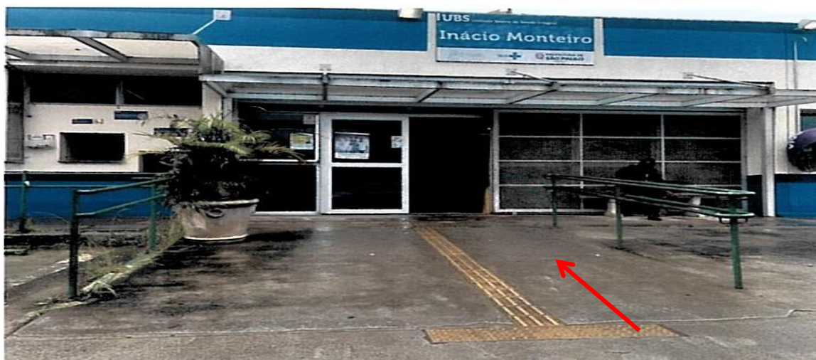
Rampa de Acesso para cadeirantes
