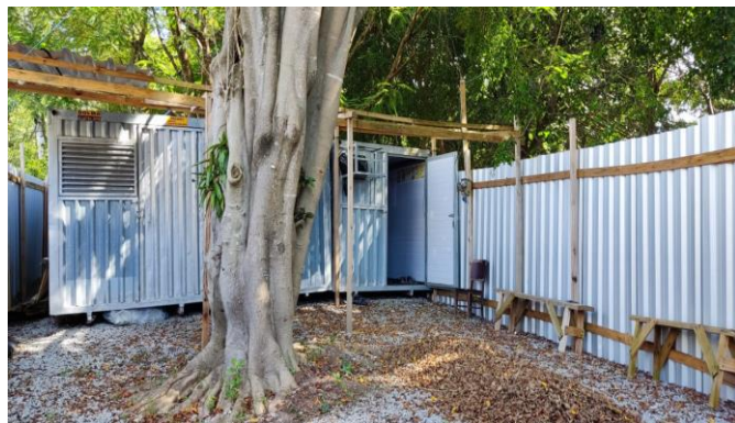
CANTEIRO DE OBRAS
