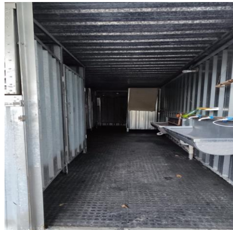
CONTAINER ÁREA INTERNA - SANITÁRIO / VESTIÁRIO
