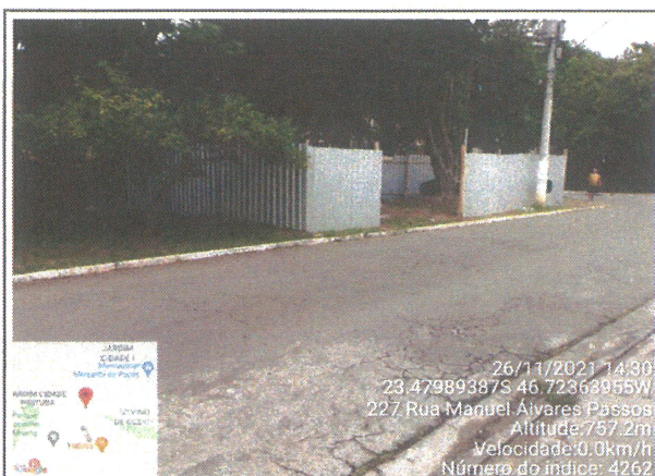
INSTALAÇÃO DOS TAPUMES METÁLICOS
