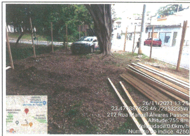
INSTALAÇÃO DOS TAPUMES METÁLICOS
