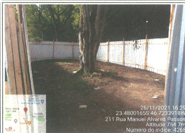
INSTALAÇÃO DOS TAPUMES METÁLICOS
