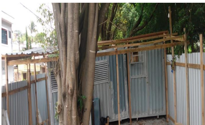
CANTEIRO DE OBRAS
