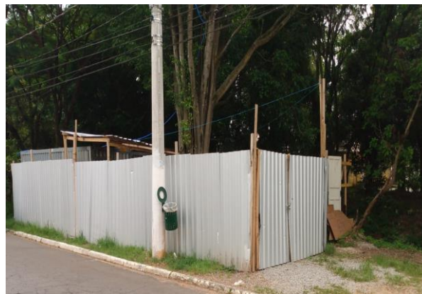
CANTEIRO DE OBRAS
