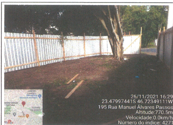
INSTALAÇÃO DOS TAPUMES METÁLICOS
