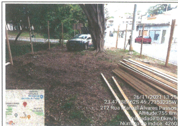
INSTALAÇÃO DOS TAPUMES METÁLICOS
