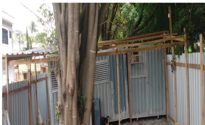
CANTEIRO DE OBRAS
