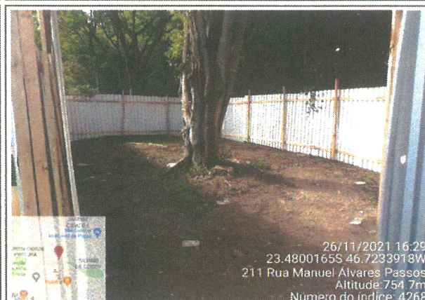
INSTALAÇÃO DOS TAPUMES METÁLICOS
