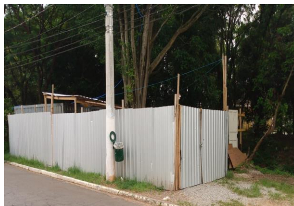
CANTEIRO DE OBRAS
