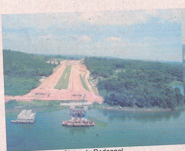
Fig. 5: Obras do Rodoanel
