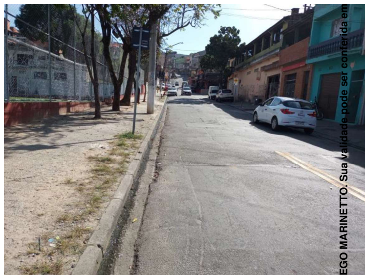
Foto 4 – Vista da Rua Manuel da Silveira. Notar quadra esportiva reformada.
