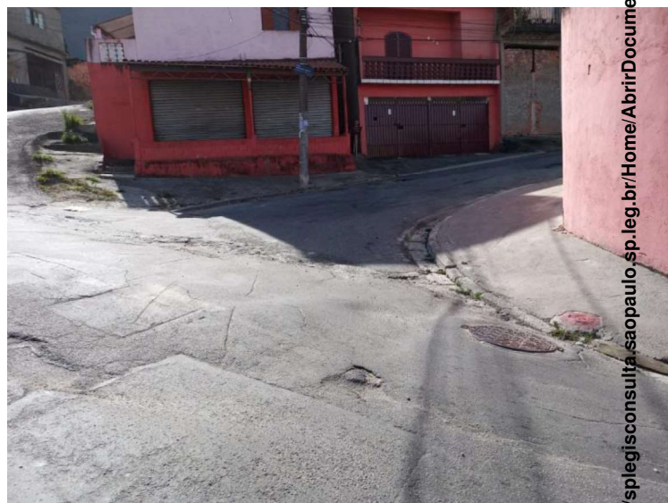
Foto 8 – Cruzamento da Rua Machado Dutra com a Rua Manuel da Silveira.
