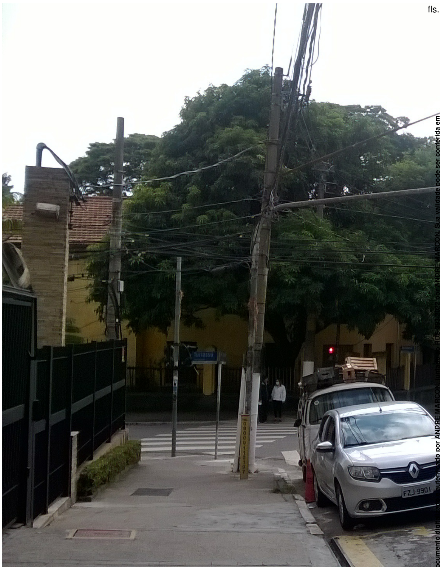
LUMINÁRIA DE LED 120 WATTS, NA RUA MINISTRO GODÓI ,420 - VISTA DA RUA MINISTRO GODÓI, 420.
