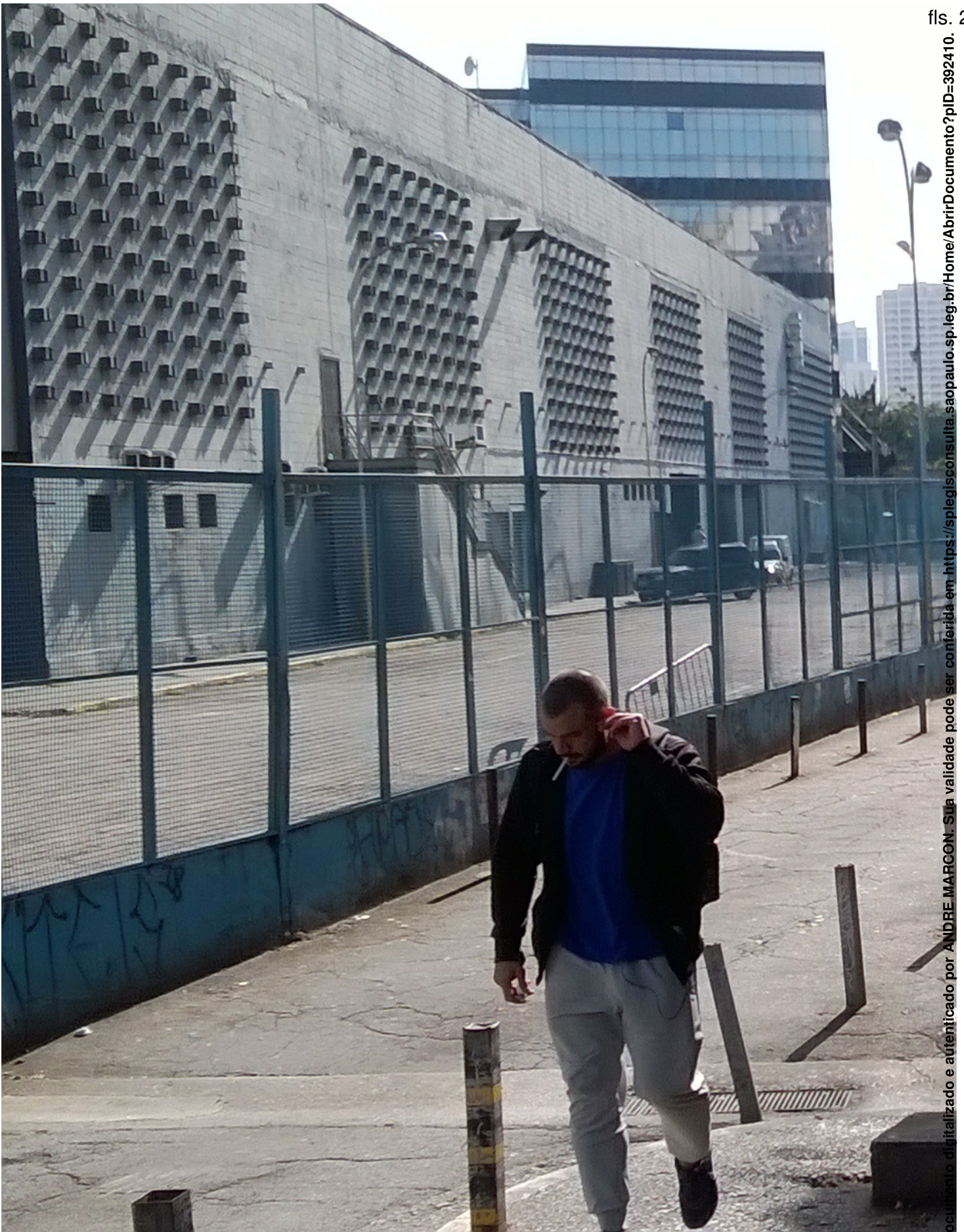
VISTA DO MEIO DA VIA
