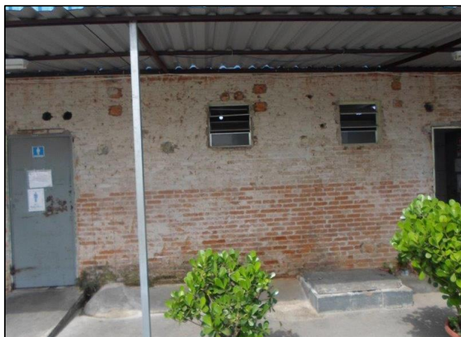
99 – ACESSO AOS BANHEIROS
