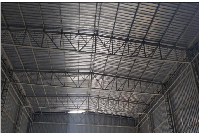
59. COBERTURA – GALPÃO METÁLICO
