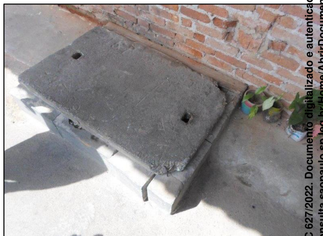
40 – CAIXA DE ESGOTO
