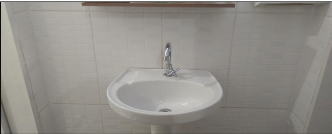
20. LAVATÓRIO – FUNCIONARIOS - TÉRREO
