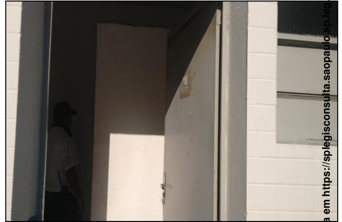
14. ACESSO AO VESTIÁRIO FEMININO
