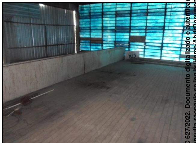
28 – MEZANINO LOCALIZADO NO DEPÓSITO 01
