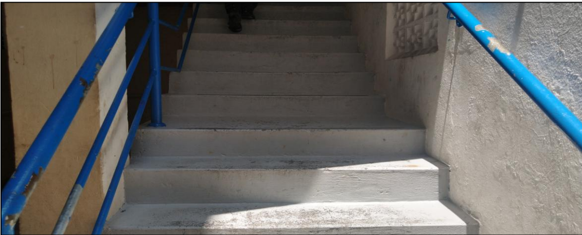
29. ESCADA DE ACESSO AO 1º ANDAR
