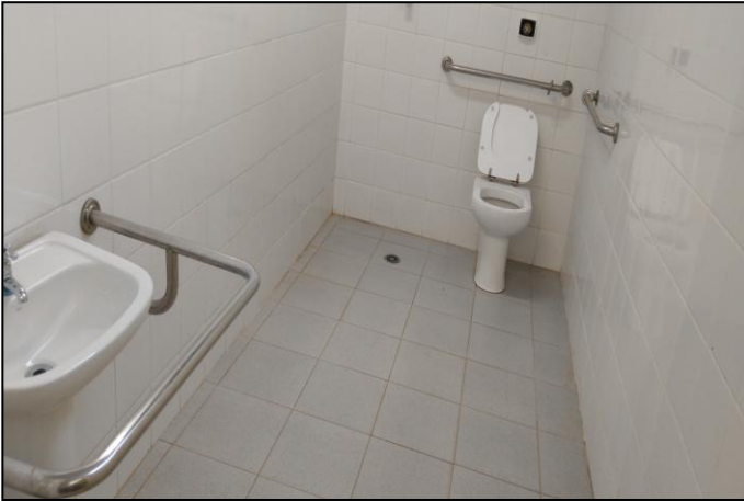
13. BANHEIRO ACESSIVEL - MASCULINO
