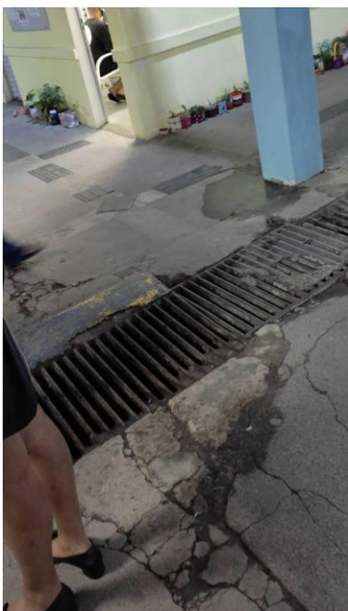
Figura 3: vala de esgoto aberta no pátio
