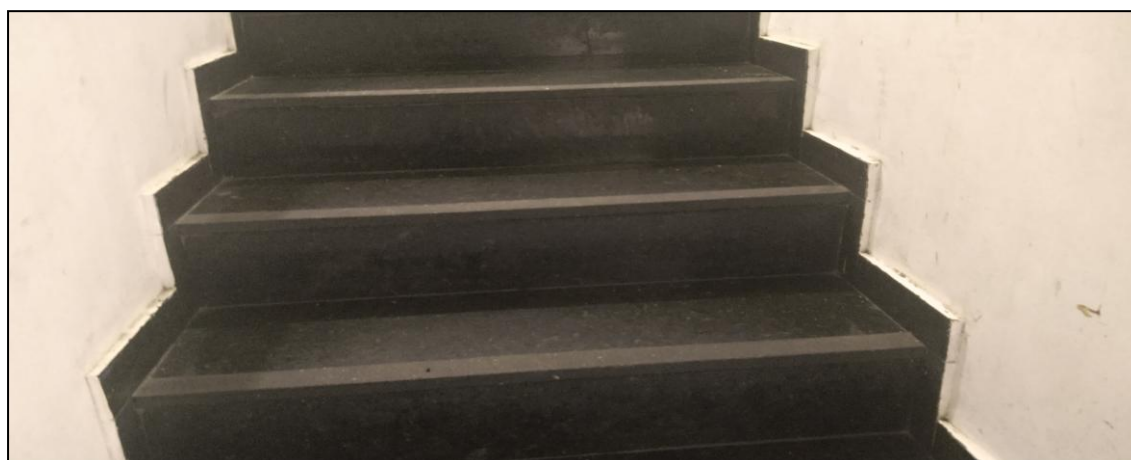
44. ESCADA DE ACESSO AO 2º ANDAR
