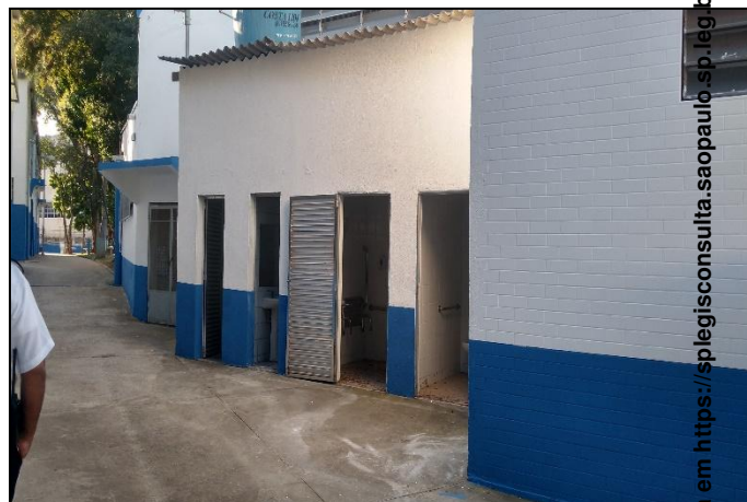
32. BANHEIROS – ÁREA EXTERNA
