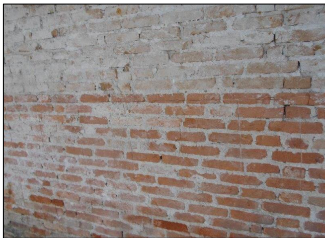
41 – PAREDE DE ACESSO AOS BANHEIROS MASCULINOS E FEMININOS
