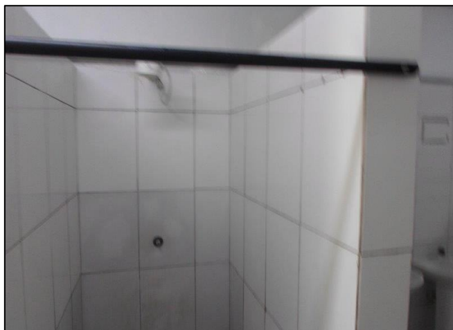
65 – BANHEIRO FEMININO – CHUVEIRO 02
