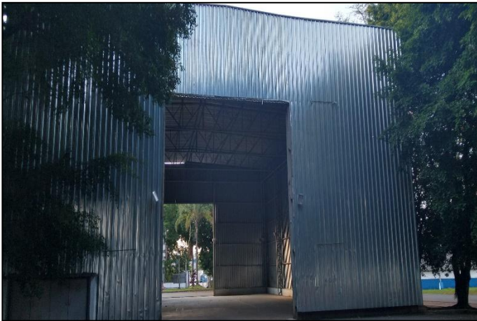
57. GALPÃO METÁLICO – ÁREA EXTERNA
