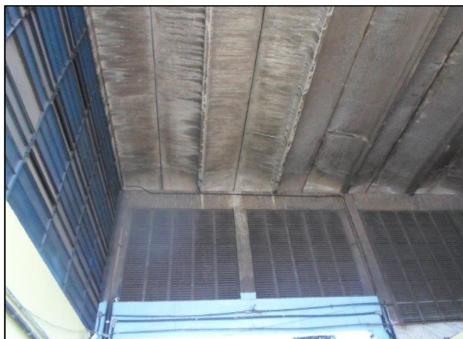
19 – DETALHE DA COBERTURA
