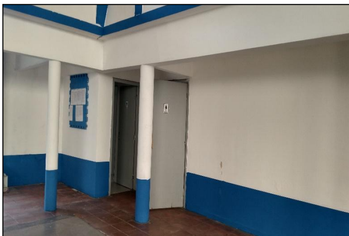
46. ACESSO AOS BANHEIROS
