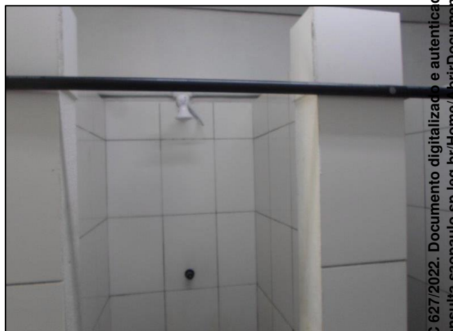
64 – BANHEIRO FEMININO – CHUVEIRO 01
