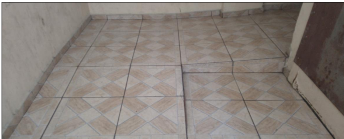
16. RAMPA DE ACESSO AOS DORMITÓRIOS - TÉRREO
