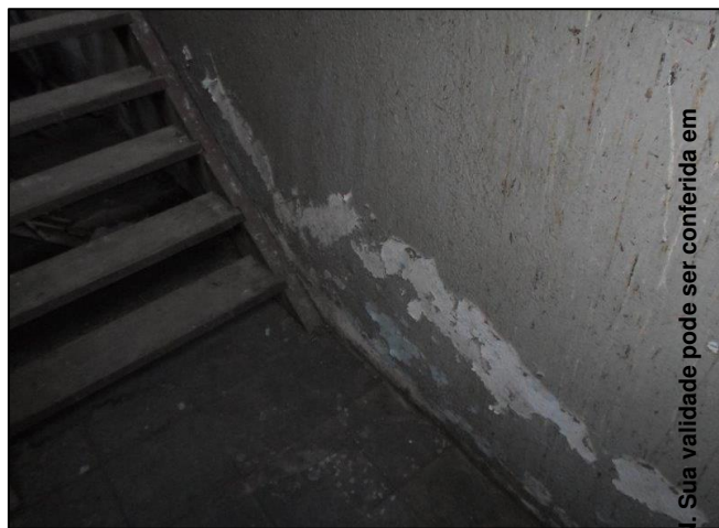
26 – ACESSO AO MEZANINO DO DEPÓSITO 01
