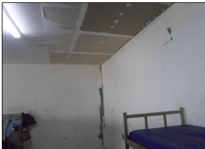
121 – ACABAMENTO NO FORRO DO DORMITÓRIO 05
