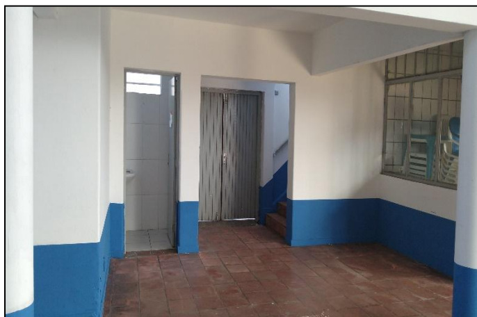
47. ACESSO AO BANHEIRO E ESCADA
