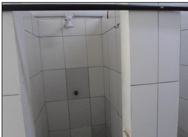
63 – BANHEIRO FEMININO – CHUVEIRO 01
