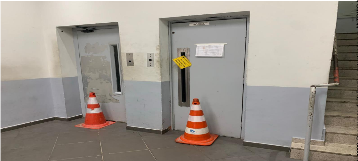
Foto 03: Vista Interna / Porta Elevador
