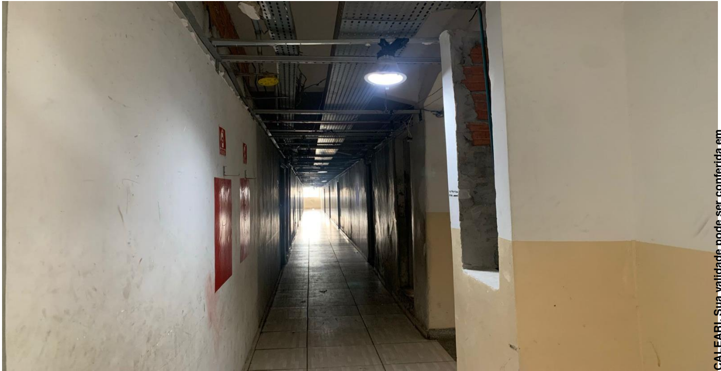
Foto 02 – Vista Interna / Corredor
