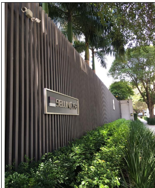
Foto 1 – Fachada do Condomínio
