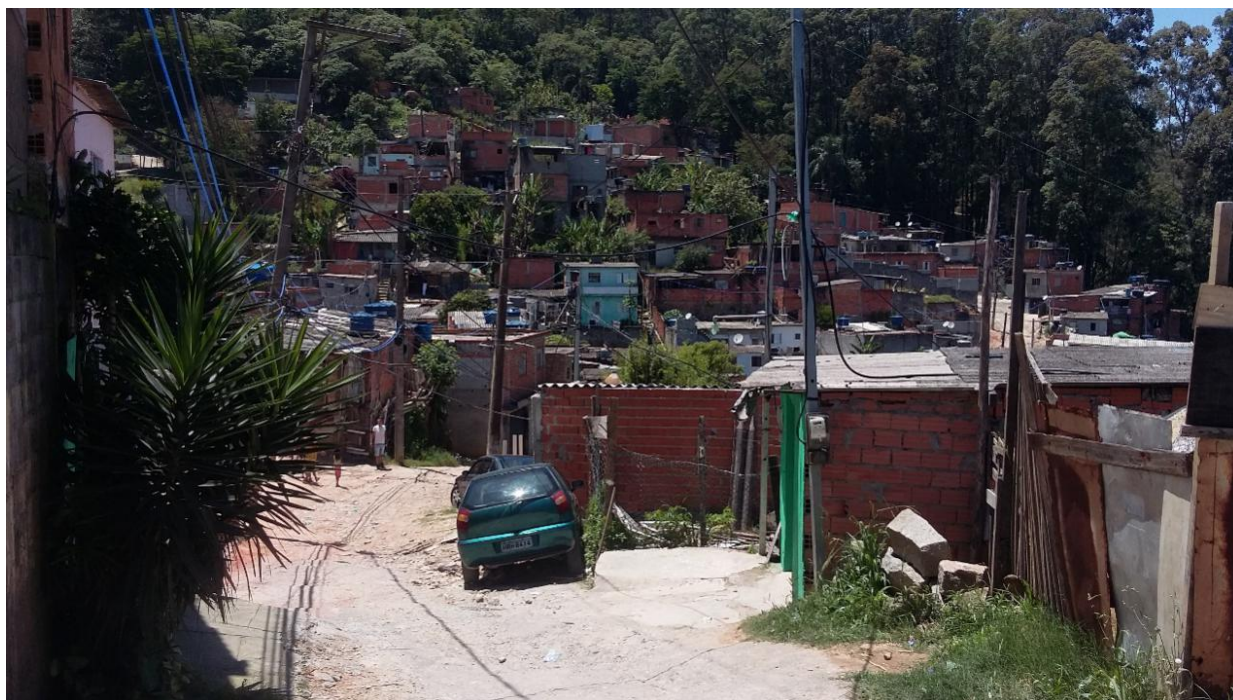
FC.PJ-05-02.1: Vista geral da parte superior do setor. Notar adensamento das moradias.
