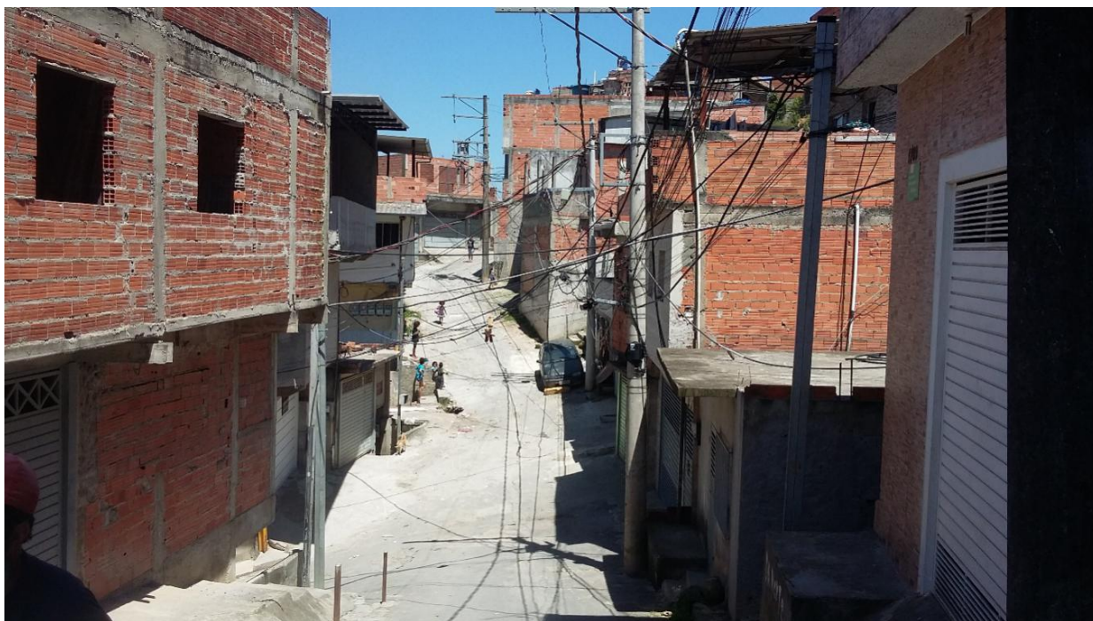
FC.PJ-05-01.3: Notar construções em alvenaria na viela
