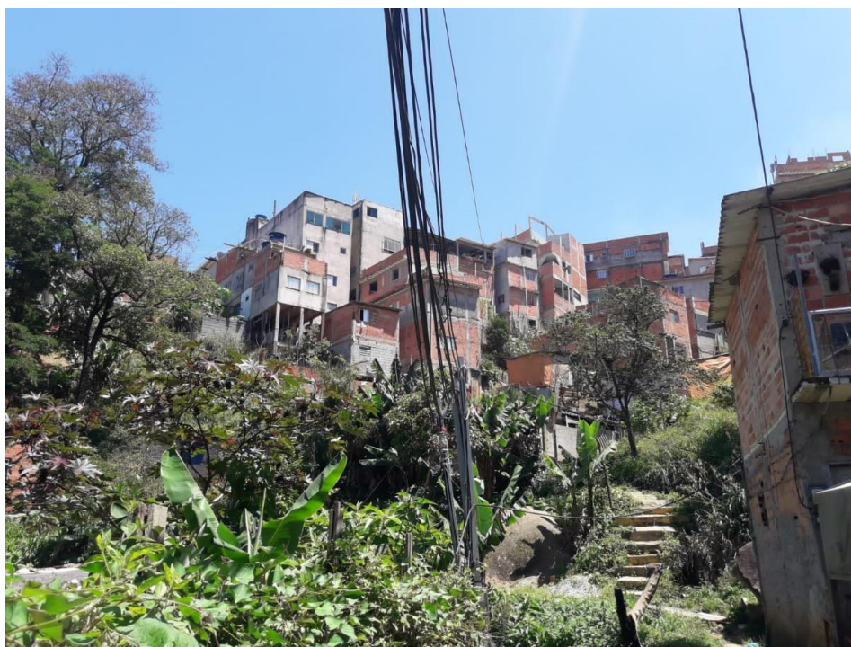
FC.PJ-05-03.2: Vista da localização das construções em topo da encosta
