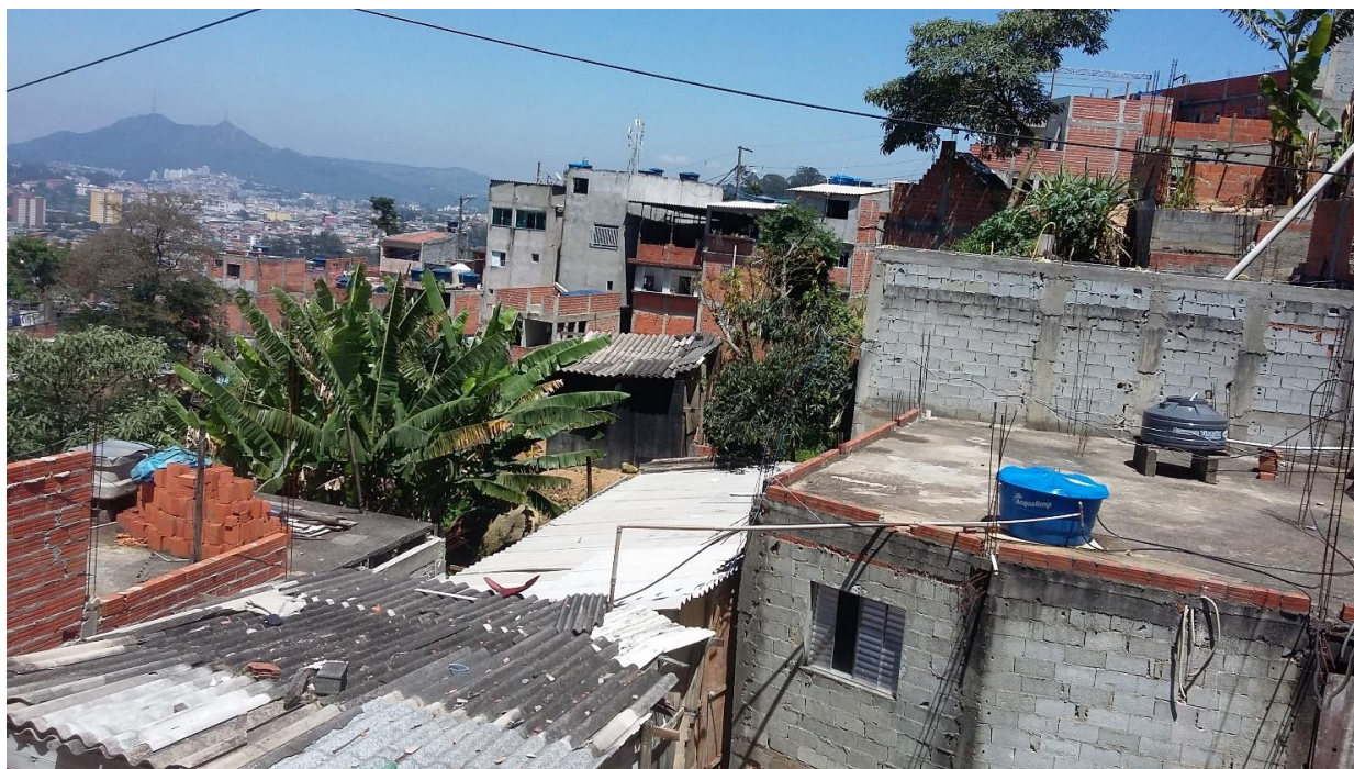
FC.PJ-05-03.3: Vista da localização das construções em topo da encosta
