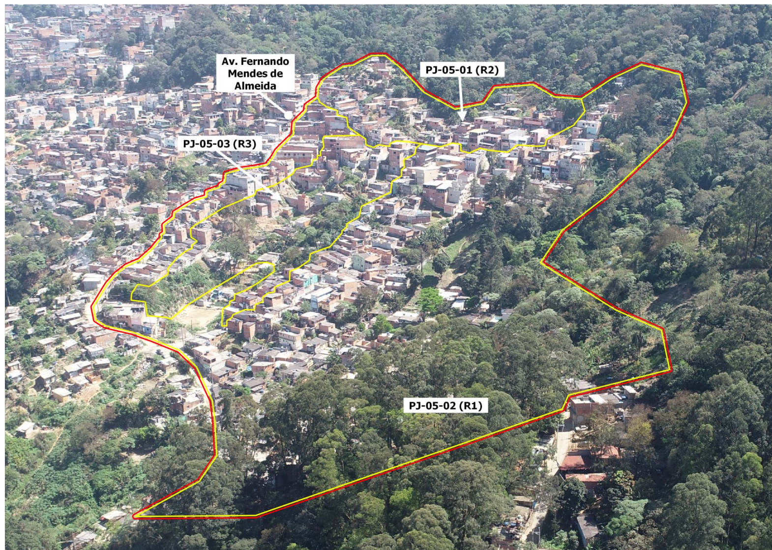
FI.PJ-05.1: Vista dos setores mapeados. Levantamento 2021.
